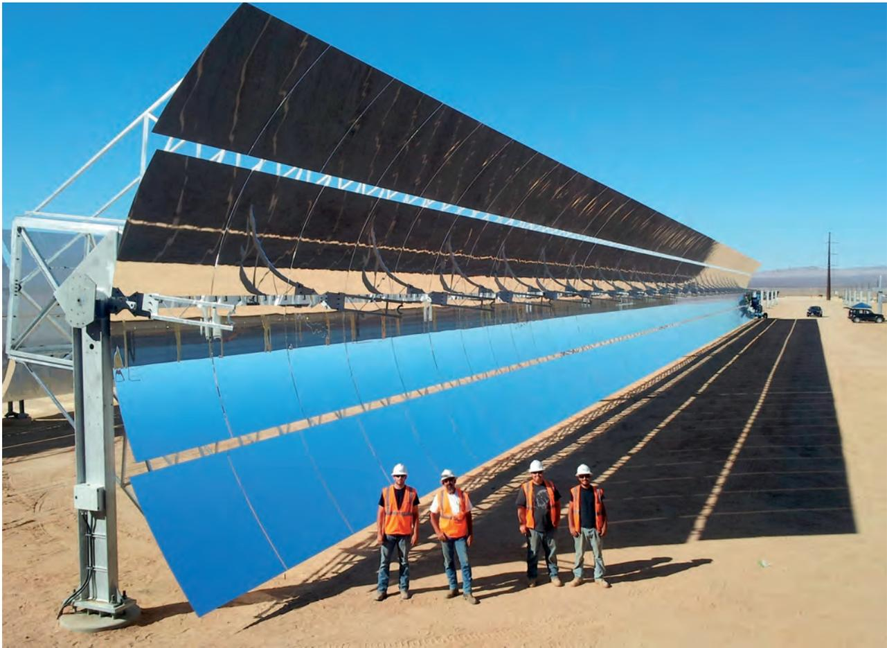
Abb. 1: Parabolrinnenkollektor „Ultimate Trough“, hier noch ohne Absorberrohr (Quelle: SBP GmbH).
