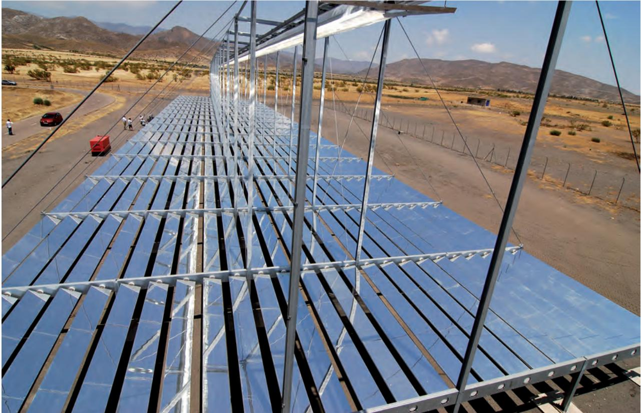
Abb. 2: Fresnel-Kollektor auf der Plataforma Solar de Almeria. Die Fokussierung der Sonnenstrahlen in dem oben angeordneten Absorberrohr erfolgt durch die Ausrichtung der streifenförmigen Planspiegel. (Quelle: DLR)
