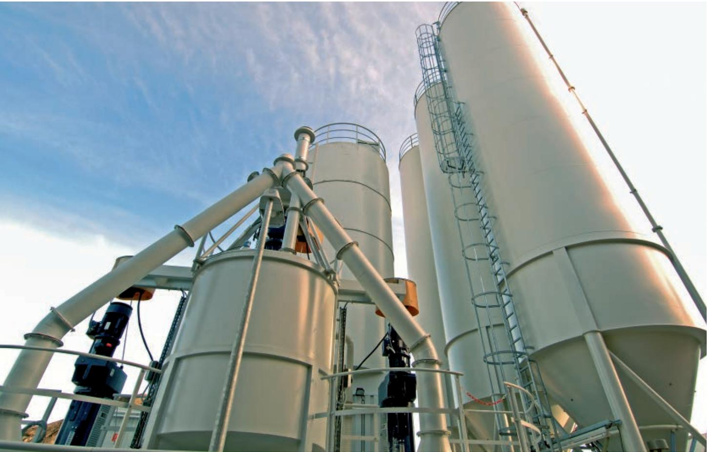
Dickstoffanlage: Staub-/Bindemittelsilo mit angeschlossenen Solenbehältern zur Herstellung versatzgeeigneter Suspension (Dickstoff)
