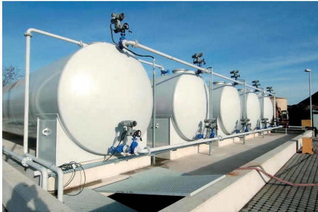
Dickstoffanlage: Tanklager für Abfallflüssigkeiten
