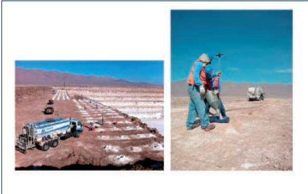
Abb. 9: Sprengstoff laden auf der Strosse
