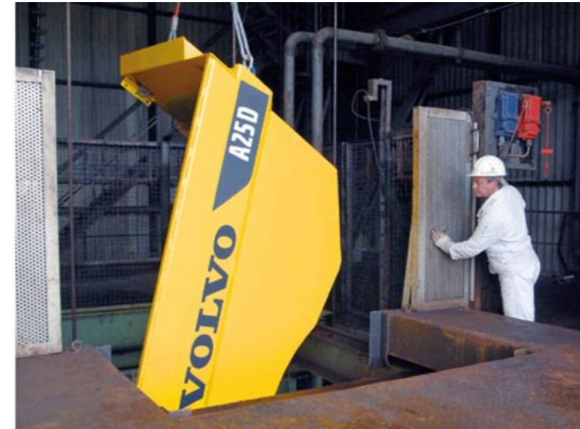
Abb. 5 + 6: Einhängen einer Muldenhälfte und des Dumperrahmens im Schacht Kolenfeld / Shaft transport of the body halves and the machine frame in the shaft Kolenfeld
