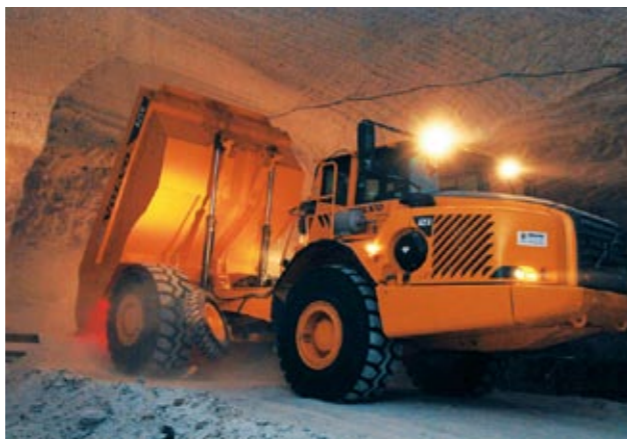
Abb. 10: Dumperkippstelle auf der 940-m-Sohle / Dumper tilting place on the 940 m level
