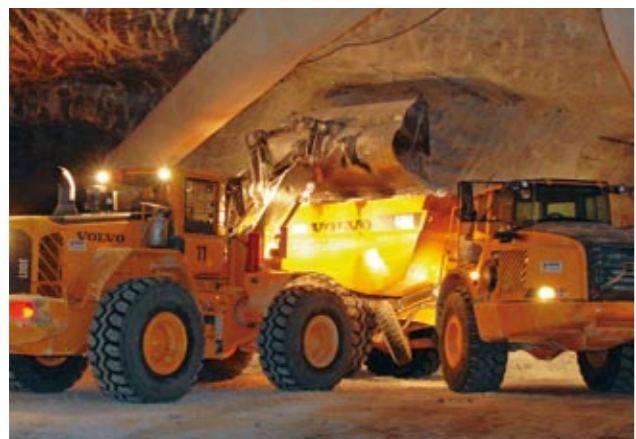
Abb. 9: Dumperbeladung in der Hartsalzvorrichtung auf der 940-m-Sohle / Dumper loading in a hard salt drift on the 940 m level
