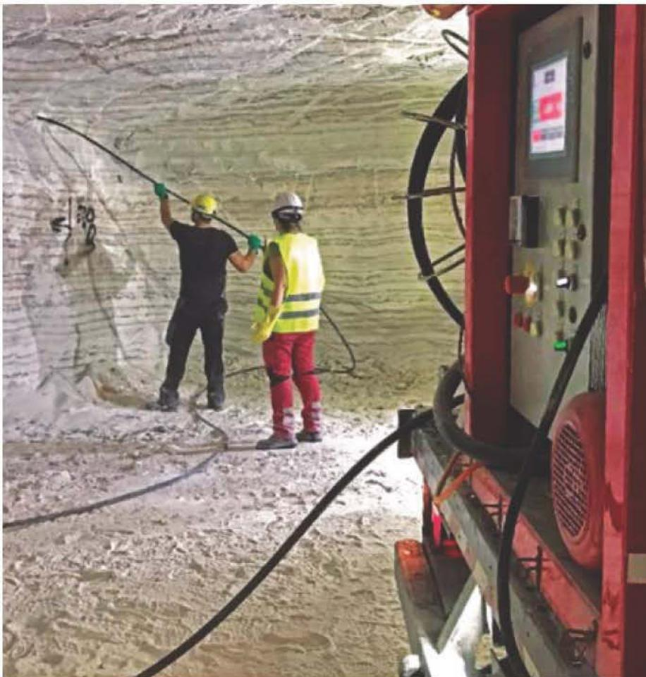
Abbildung 9: Ladearbeiten mit Emulsionssprengstoff, Mischladetechnologie
