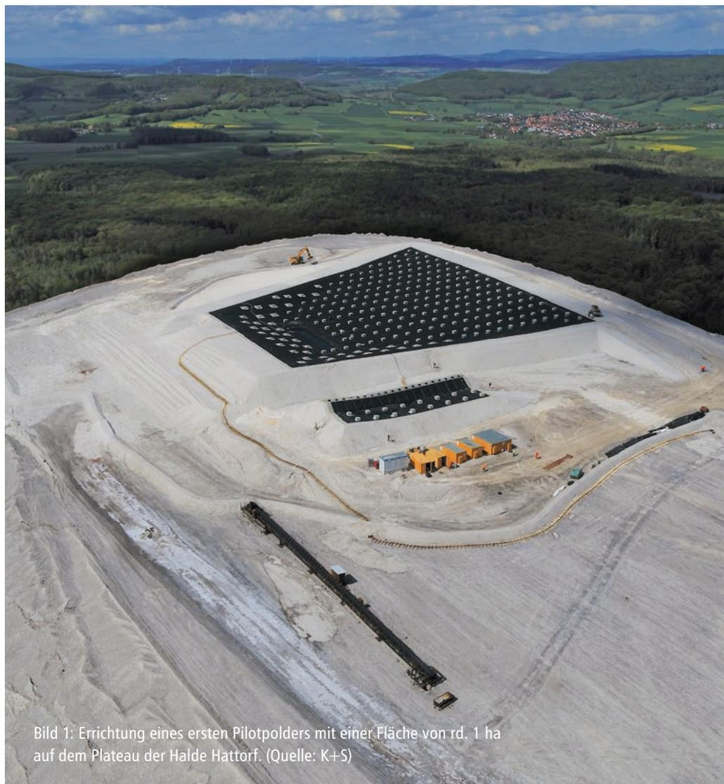
Bild 1: Errichtung eines ersten Pilotpolders mit einer Fläche von rd. 1 ha auf dem Plateau der Halde Hattorf. (Quelle: K+S)
