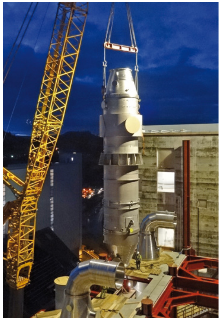
Abbildungen 1 und 2: Bau- und Montagephase der neuen KKF-Anlage. Links: Einheben des größten Apparates, ein Verdampfer, in den Rohbau der Anlage im Februar 2017; rechts: Montage eines 110 t schweren Rohrbündel-Wärmetauschers
