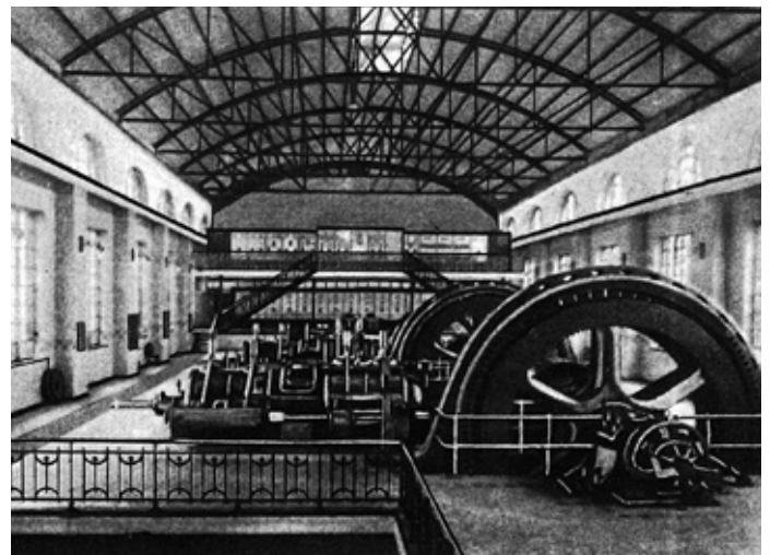
Wittekind, elektrische Zentrale.
