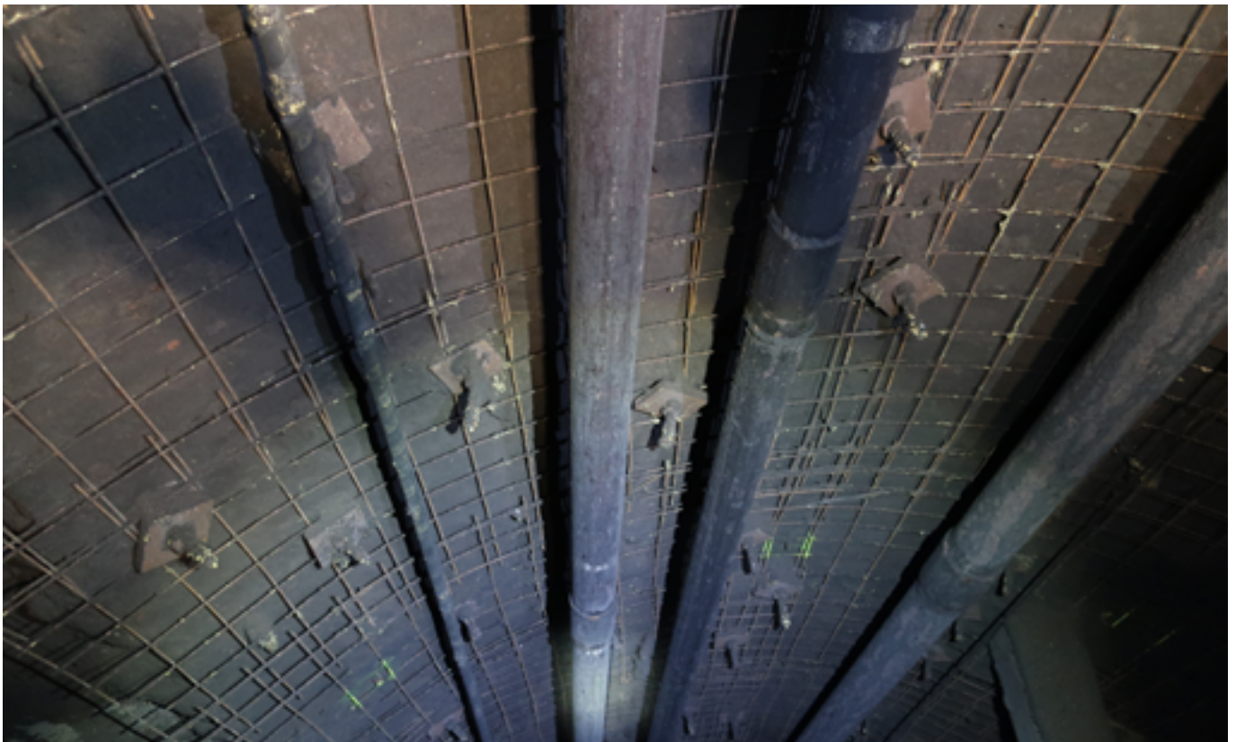
Abbildung 7: Saniertes Mauerwerk, Blick im Schacht 5 nach unten
