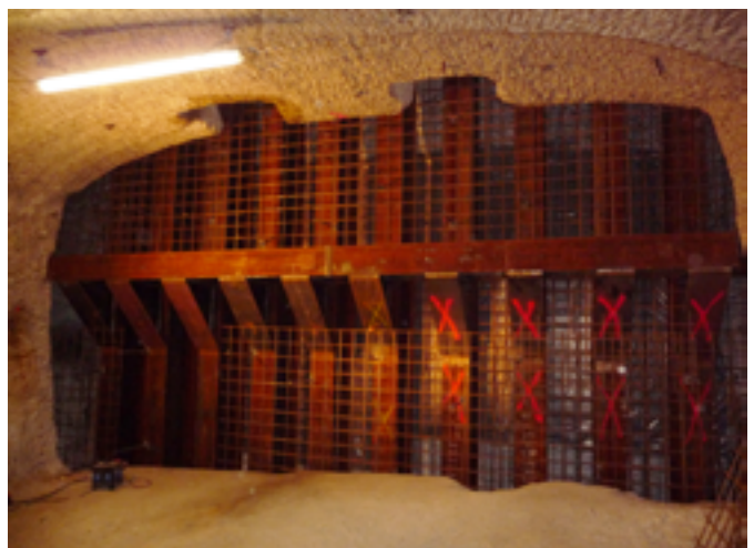
Abbildung 2: Dammbauwerk für 100 m Stauhöhe im Rohbau, bereits eingebaute Bewehrung und HEB-/HEM-Träger, Abstützung Luftseite im Bau
