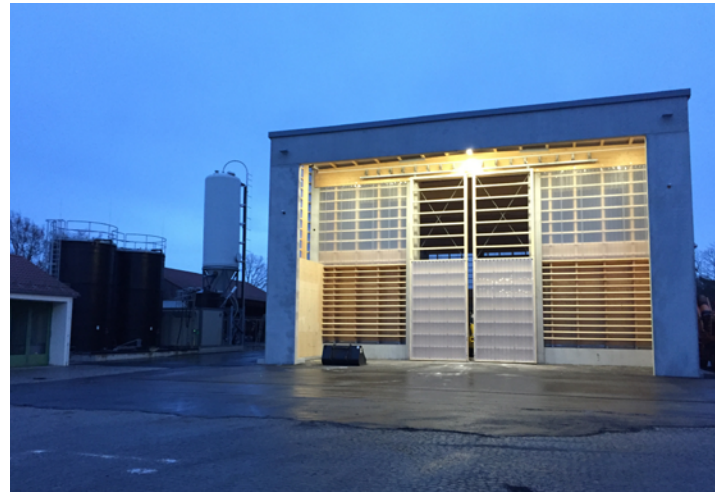
Salzlagerhalle in der AM Erlangen der Autobahn GmbH an der A84, im Hintergrund die Soleanlage mit Salzsilo (Salt Research + Consulting)
