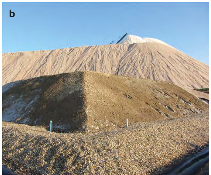
Abb. 1 Prinzip „Infiltrationshemmschicht“ (a, verändert nach [1]) und Pilothalde mit ausgebildeter Infiltrationshemmschicht (b)
