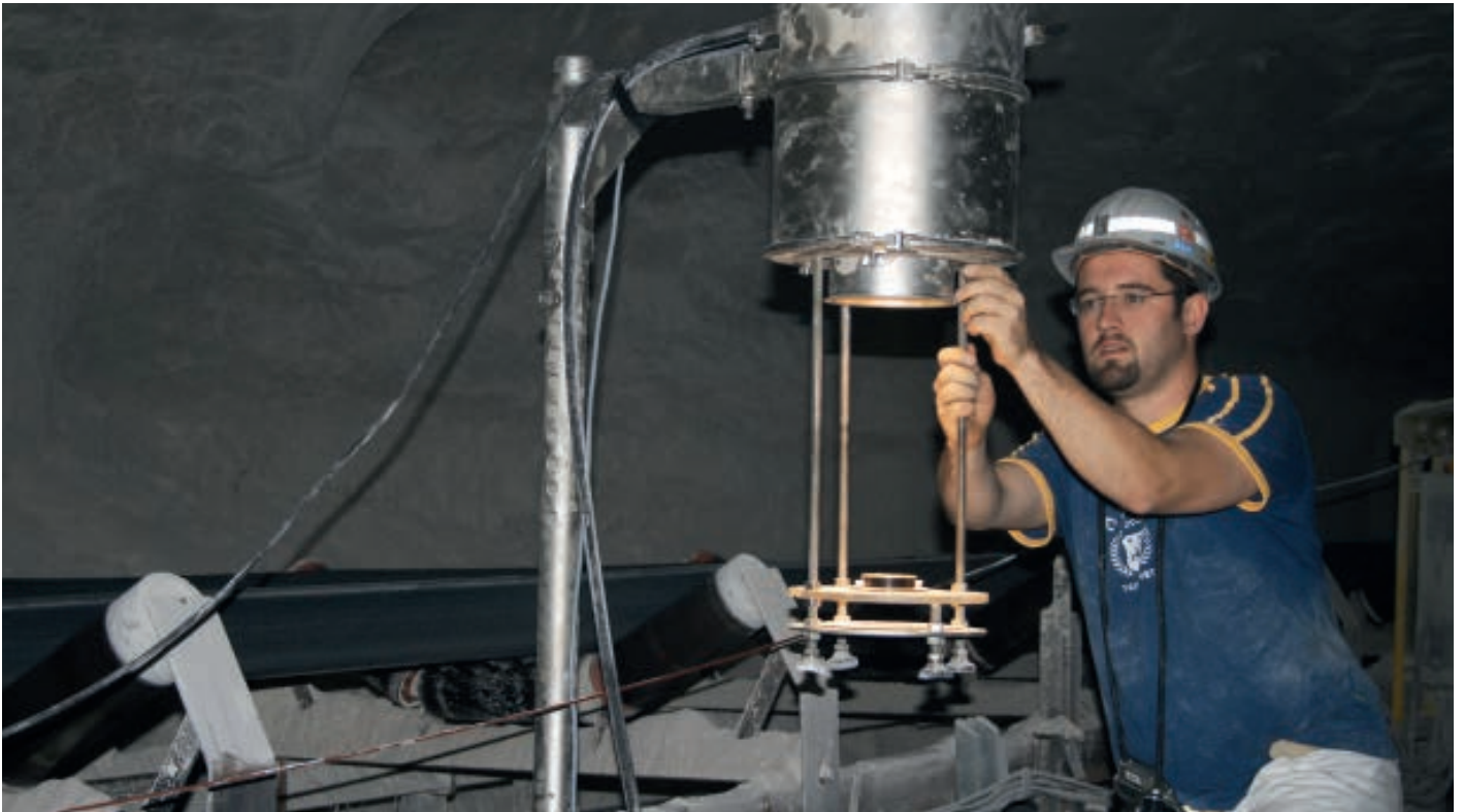
AFZ-Mitarbeiter bei der Installation einer PAT-Sonde unter Tage
