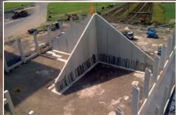
Rohbau der Salzlagerhalle mit betonierten Trennwänden für die getrennte Lagerung von Sortensalzen (Baustatus Juni 2014).
