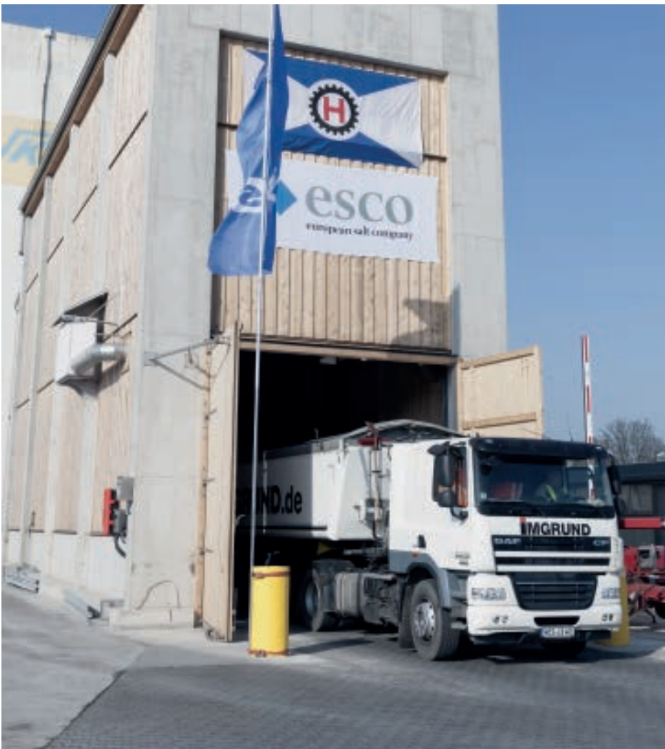
Entladehalle der Fa. Hülskens im Weseler Stadthafen. Hier werden die beladenen LKW in einen Tiefbunker entleert.
