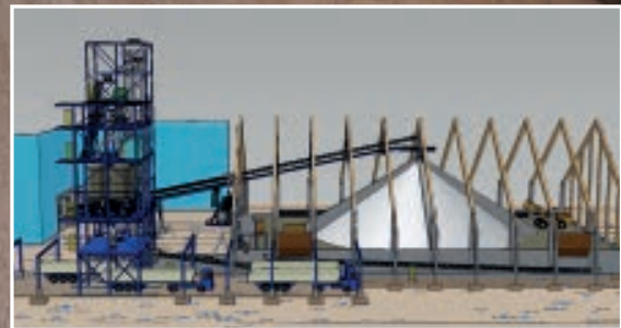
Isometrische Darstellung der Salzlagerhalle mit Bespeicherungseinrichtung.
