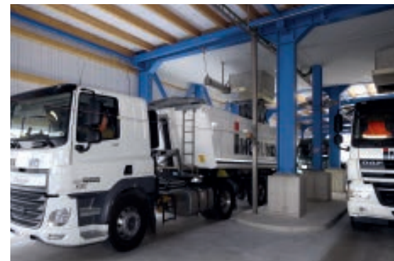
Jeweils zwei Kipper-LKW können parallel in der automatischen Beladeeinrichtung abgefertigt werden.
