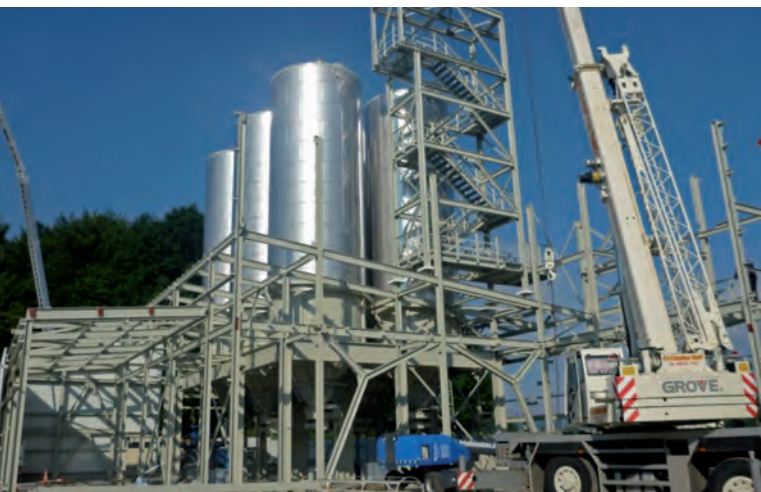
Abbildung 5: Montage des Stahlbaues
