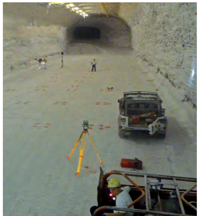
Abbildung 7: Fertiggestellte Auffahrung Standort Dickstoffanlage
