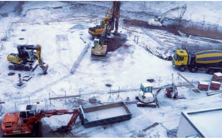
Abbildung 4: Bohrpfehlgründung
