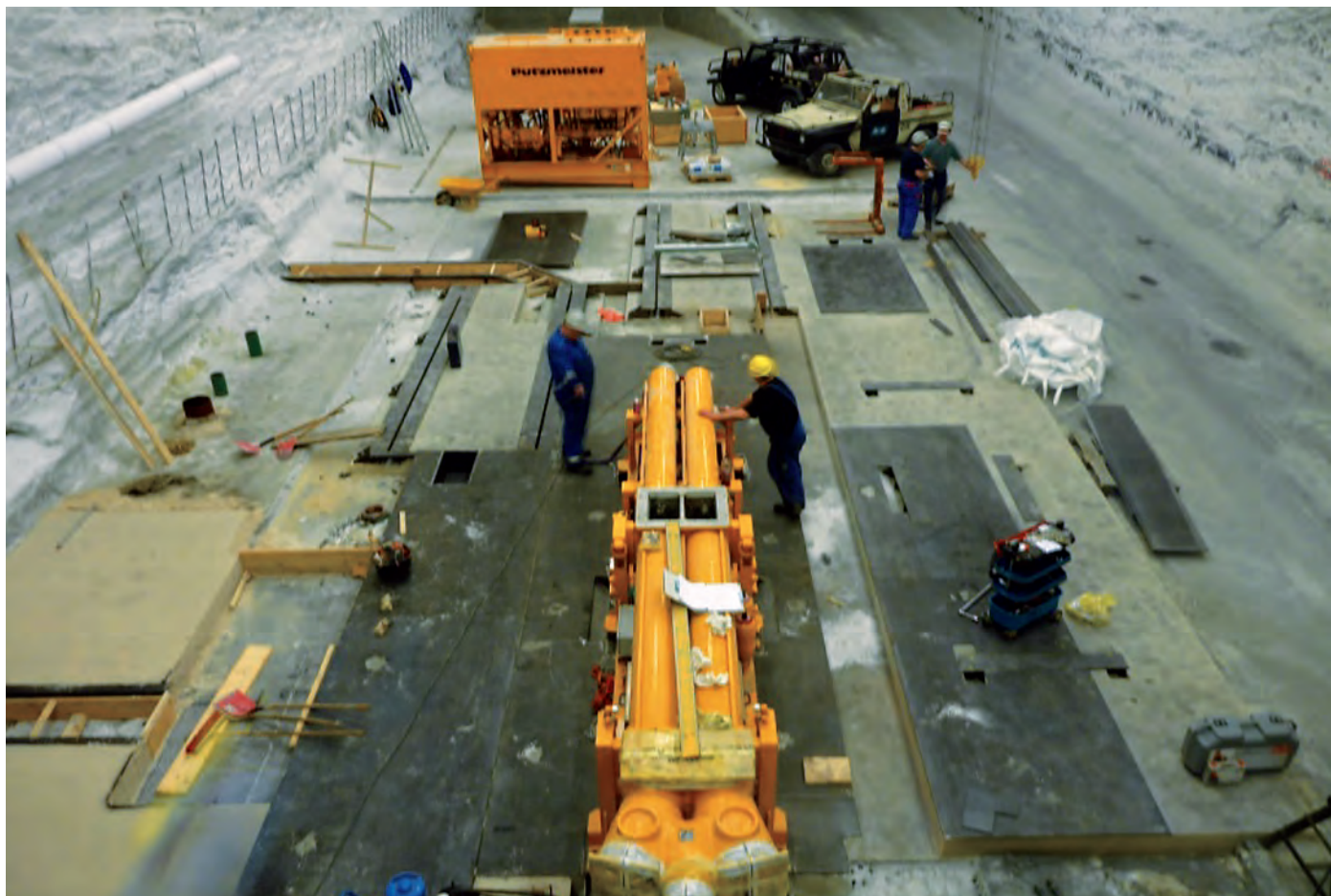
Abbildung 8: Montage der Dickstoffpumpen
