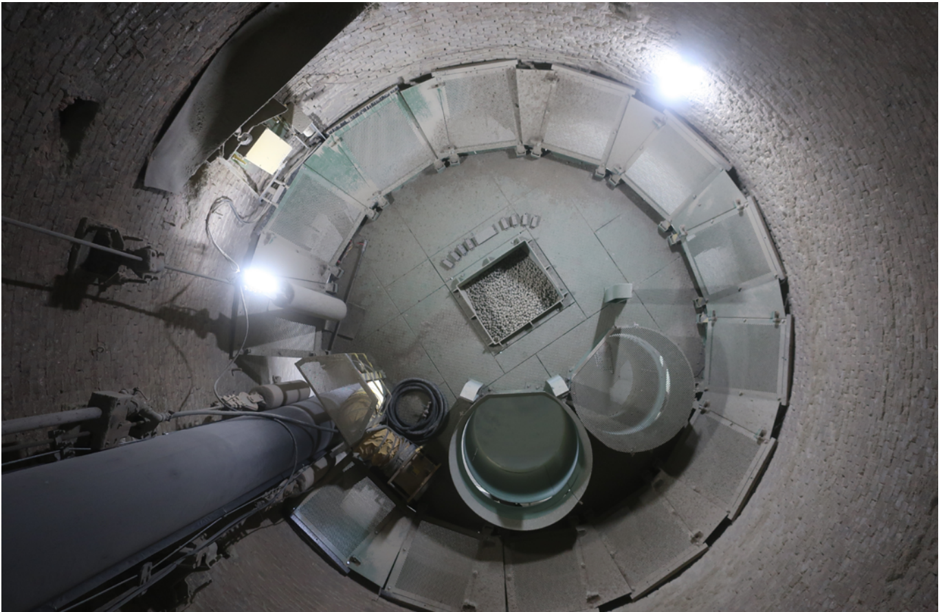
Abbildung 11: Blick von oben auf Kopfschutzbühne mit Bentonitbunker
