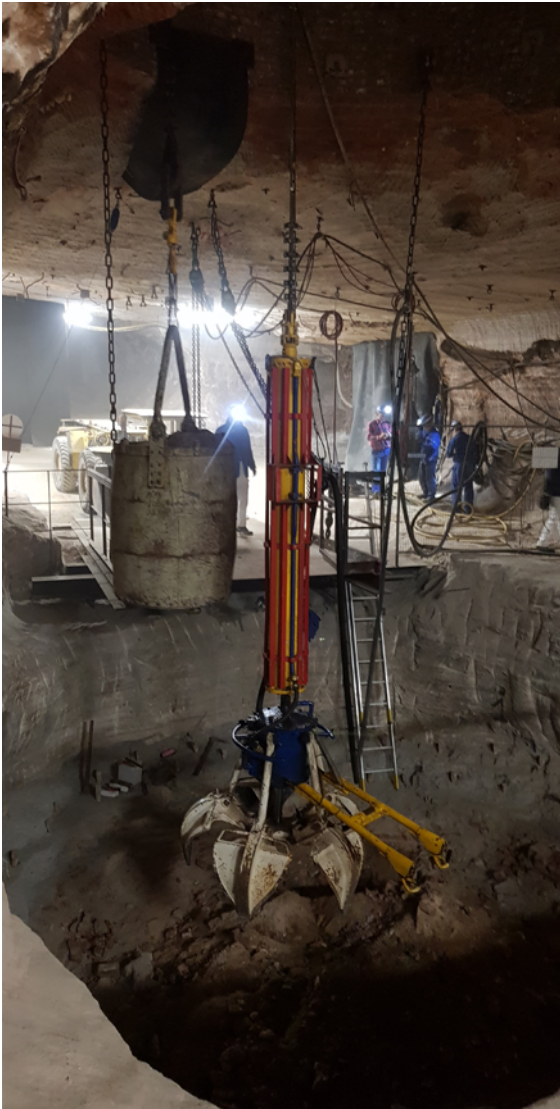
Abbildung 5: Beräumarbeiten Schachtsumpf, Blick auf 2. Sohle Füllort
