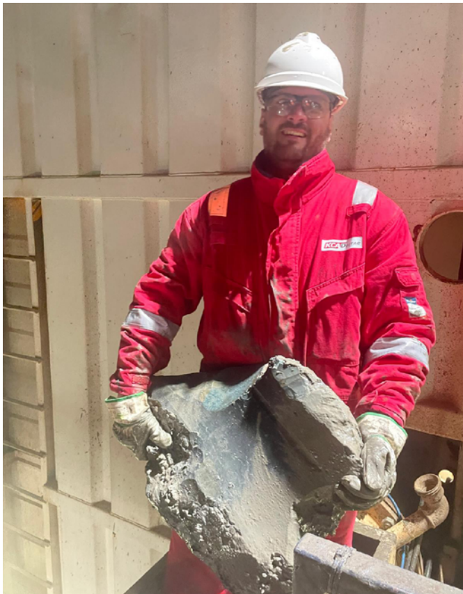
Abbildung 6: Entfernung eines massiven Zementblocks aus der Auslaufrinne des Bohrturms.
