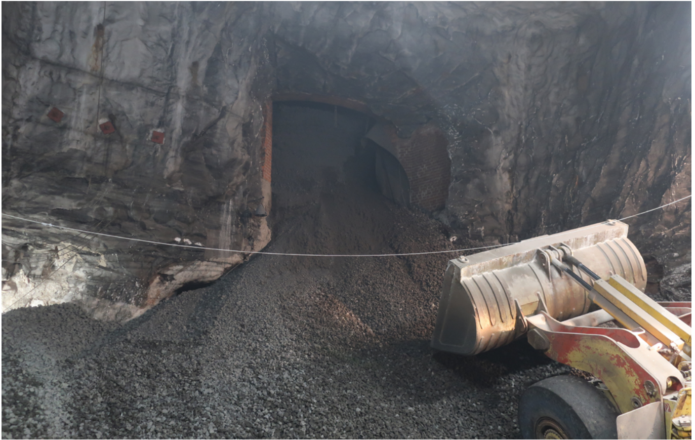
Abbildung 7: Einbau unteres Widerlager 1. Sohle Füllort
