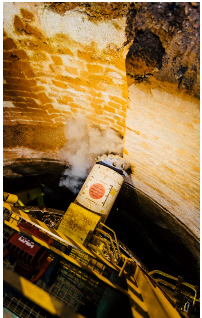
Abbildung 9: Fräsarbeiten im Mauerwerk
