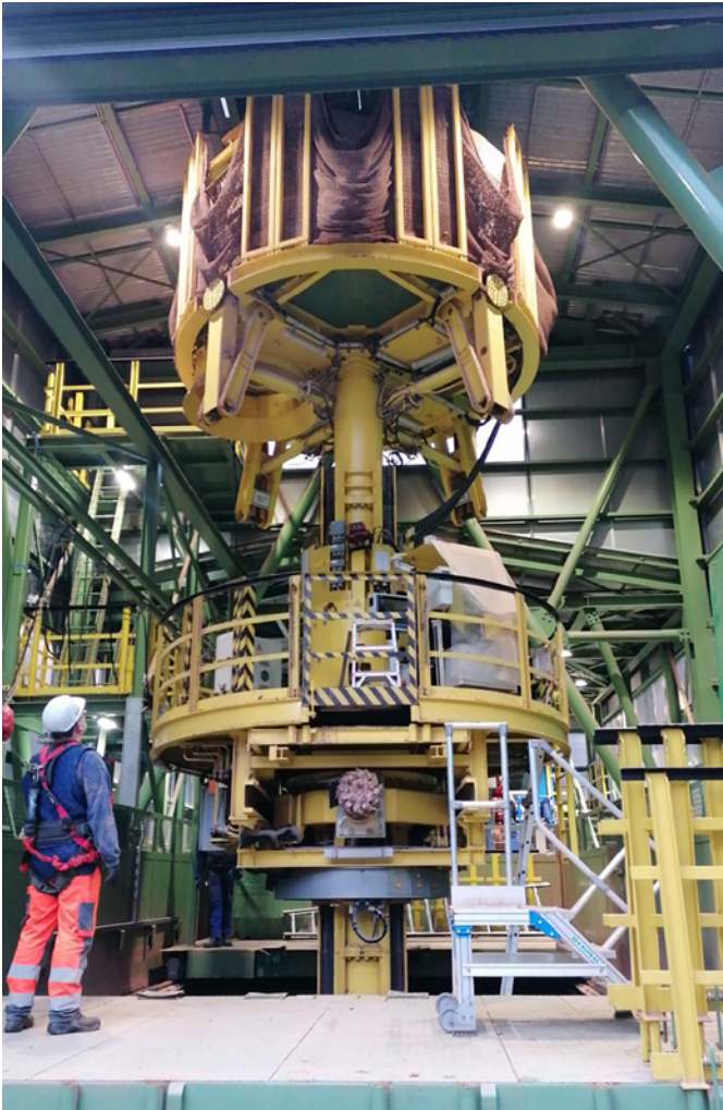
Abbildung 8: Schachtfräse in der Schachthalle der großen Baustelleneinrichtung
