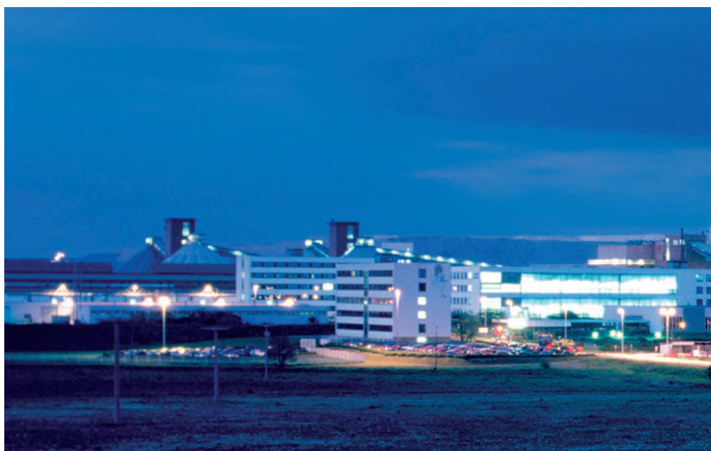
Abb. 18: Das Kaliwerk Zielitz nördlich von Magdeburg (Sachsen-Anhalt) ist mit rund 1.800 Mitarbeitern einer der größten Standorte der K+S KALI GmbH
