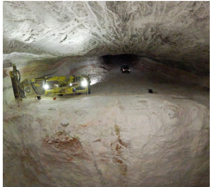
Abbildung 18: Blick auf Strosskante mit LAG-Bohrwagen aus Sicht der Drohne
