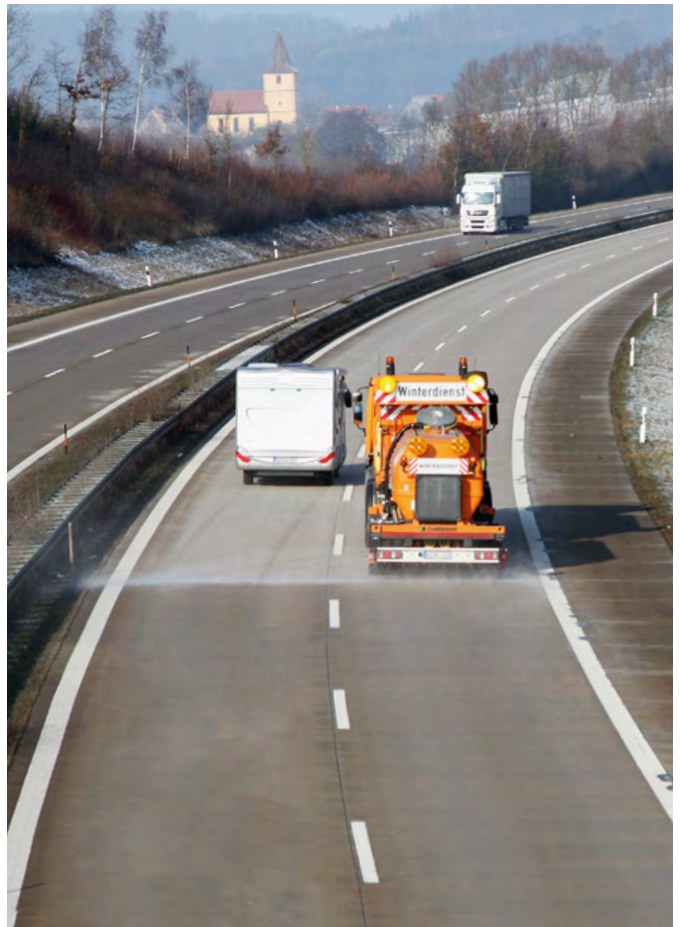
Abbildung 8: Mono-Streumaschine für FS100 im Einsatz (Quelle: Landesbaudirektion Bayern)
