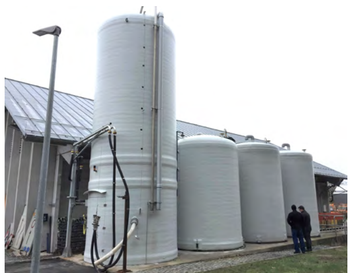
Abbildung 4: Silolöser und Solelagerung in der Autobahnmeisterei Kist
