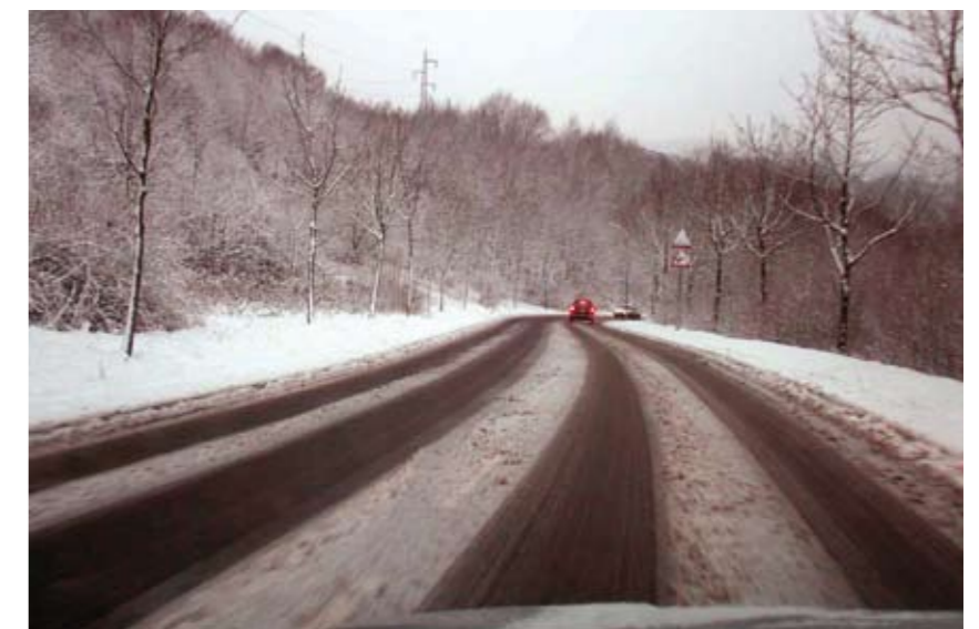
Abb. 3: Straßenzustand im Winter / typical road condition in winter time
