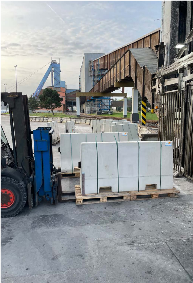
Abbildung 8: Transport der Betonfertigteile über Schacht Franken [Foto: SWS]
