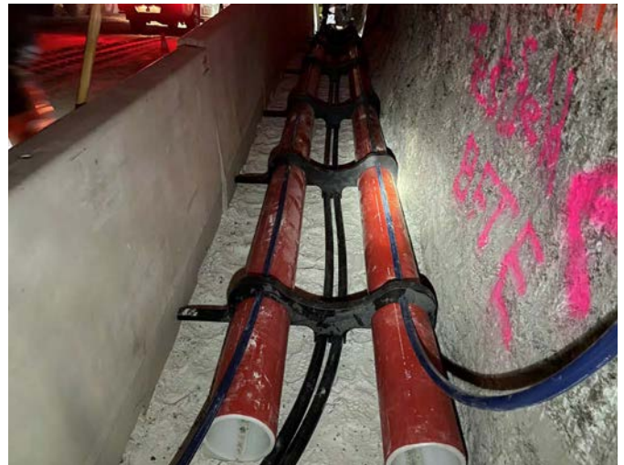
Abbildung 4: Leerrohr-Einbau hinter Betonelementen [Foto: SWS]
