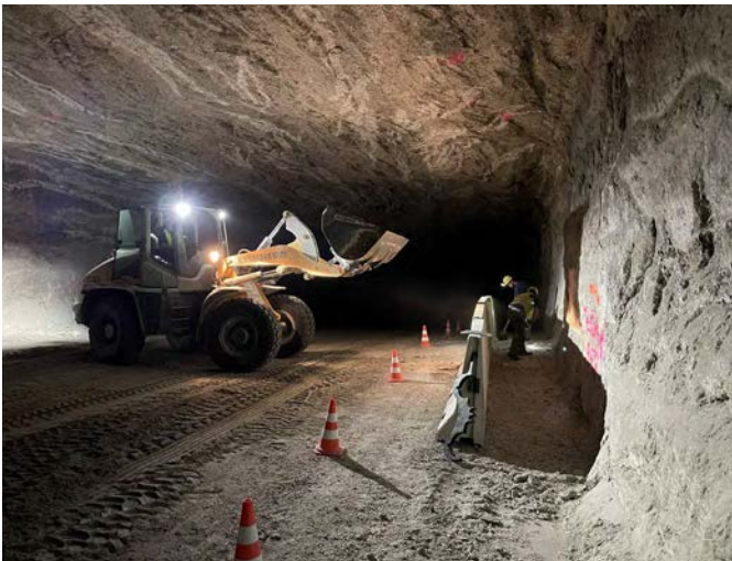
Abbildung 3: Versuchsaufbau Betonfertigteil-Trasse [Foto: SWS]
