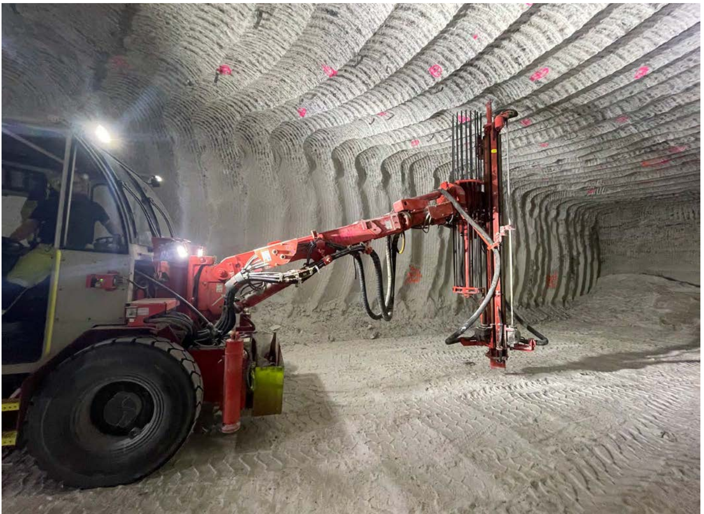
Abbildung 2: Ankerbohrwagen in der Streckenauffahrung [Foto: SWS]
