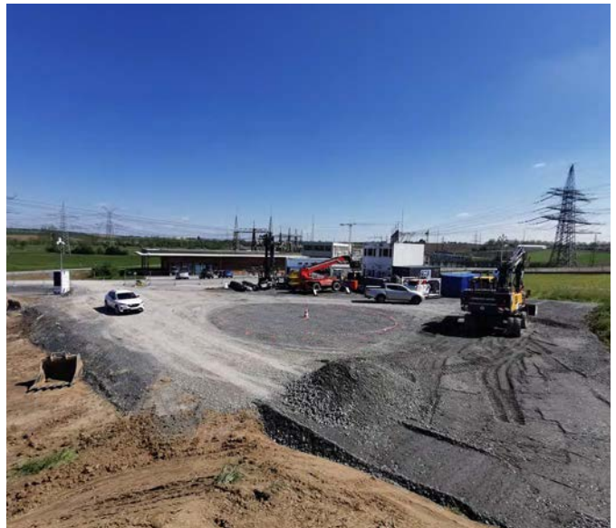
Abbildung 7: Bohrplatz auf der Schachtbaustelle Großgartach
