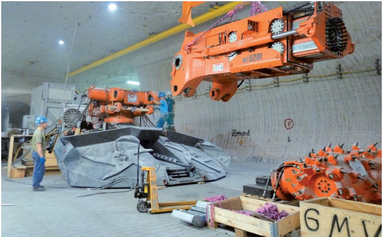
Abb. 7: Montage der Teilschnittmaschine MT520
