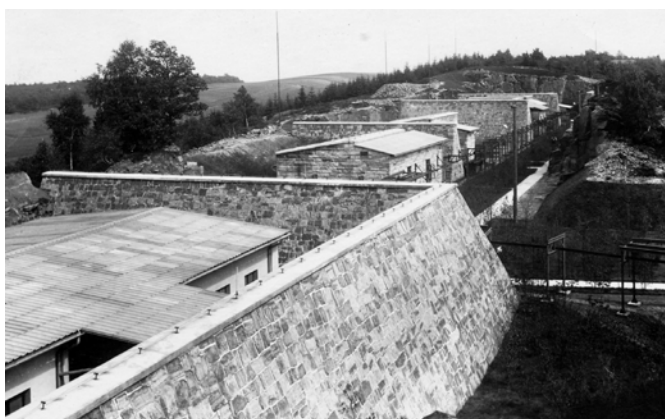
Typische Bauweise im Sprengstoffwerk Langelsheim mit Erdwällen und Schutzmauern [5]
