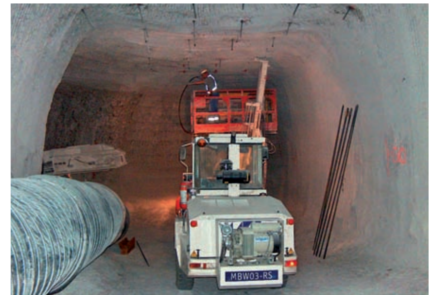
Abb. 6 b: Bohrwagen für Ankerarbeiten / Vehicle for drilling and bolting
