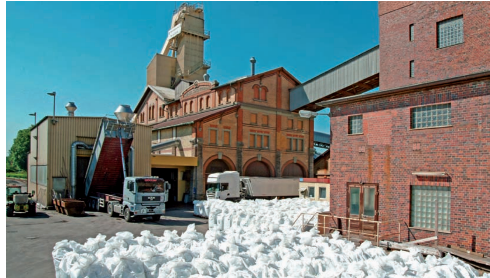
Abb. 1: Schacht Kochendorf, Entladung von bergbaufremden Abfällen / Kochendorf shaft, unloading of non-mining bulk material
