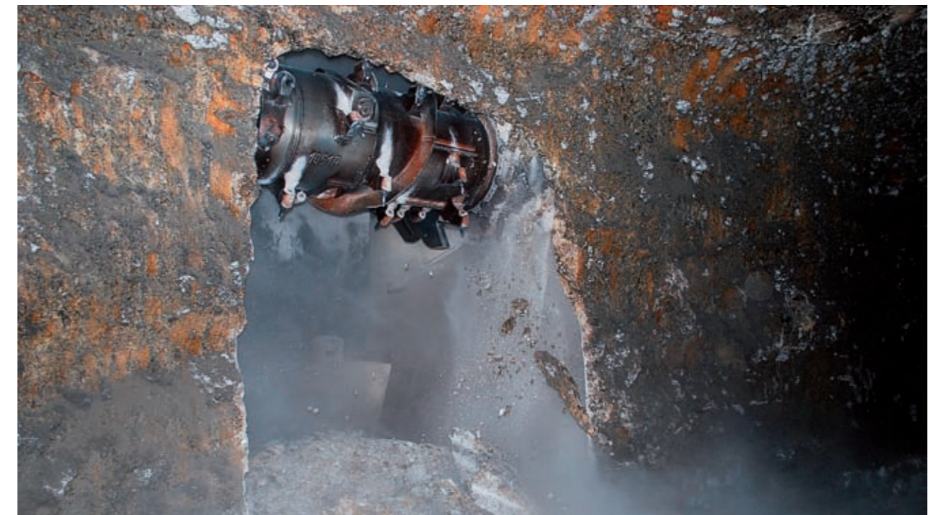
Abb. 8 a: Durchschnitt ins Bergwerk Kochendorf / Cut-through in the Kochendorf mine
