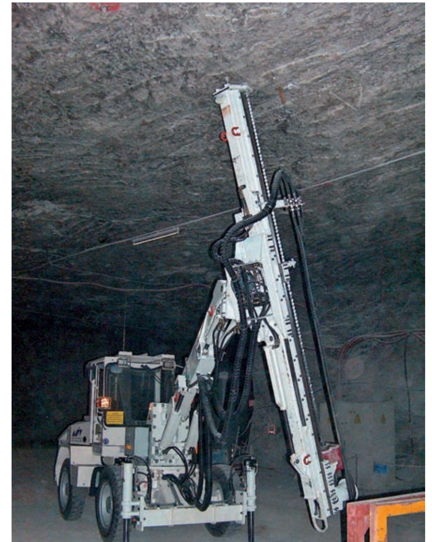
Abb. 6 a: Bohrwagen für Ankerarbeiten / Vehicle for drilling and bolting
