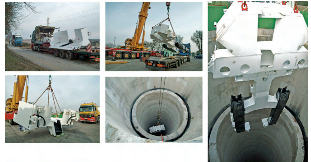
Abb. 7: Transport der Maschine in Einzelteilen nach unter Tage / Transport of the machine components through the shaft
