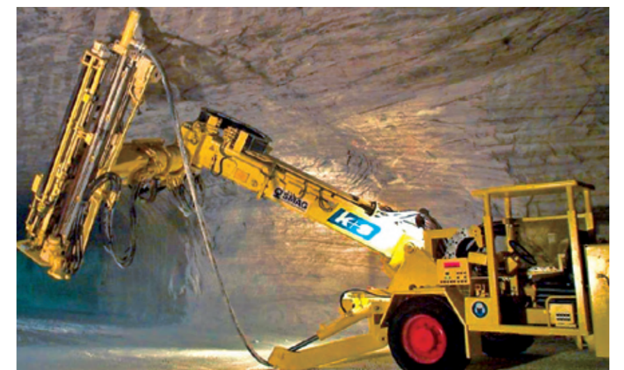
Abb. 8: Bohrung nach oben mit dem BW 50 S 1 | Drilling upward with BW 50 S 1
