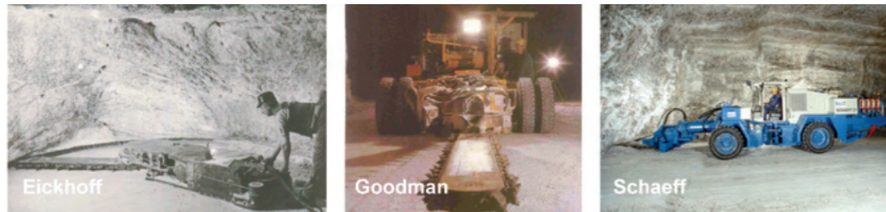
Abb. 3: Einsatz von Schrämmaschinen/Schlitzfräsen zur Unterstützung der Sprengarbeit / Use of undercutters as blasting support
