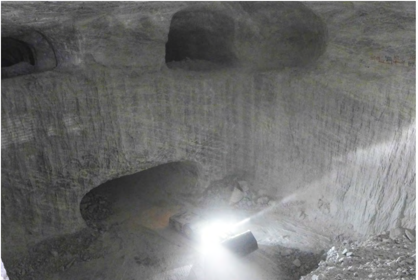
Abbildung 7: Ladearbeit im Kammerstrossenbau
