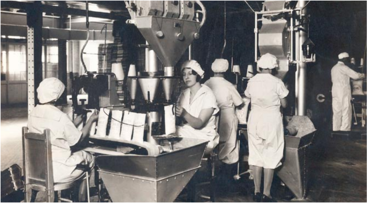
Salzabfüllung 1933: Das Speisesalz rieselt aus den Trichtern direkt in die handgenähten Baumwollbeutel / Salt bagging in 1933: table salt pours from the funnels direct into the hand-sewn cotton bags
