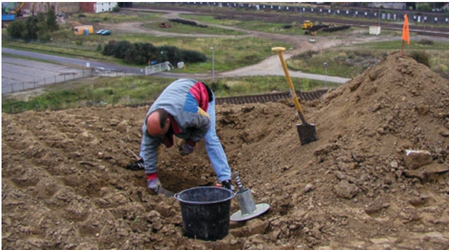
Bodenmechanische Kontrolle des eingebauten Verwertungsmaterials (Foto K+S)
