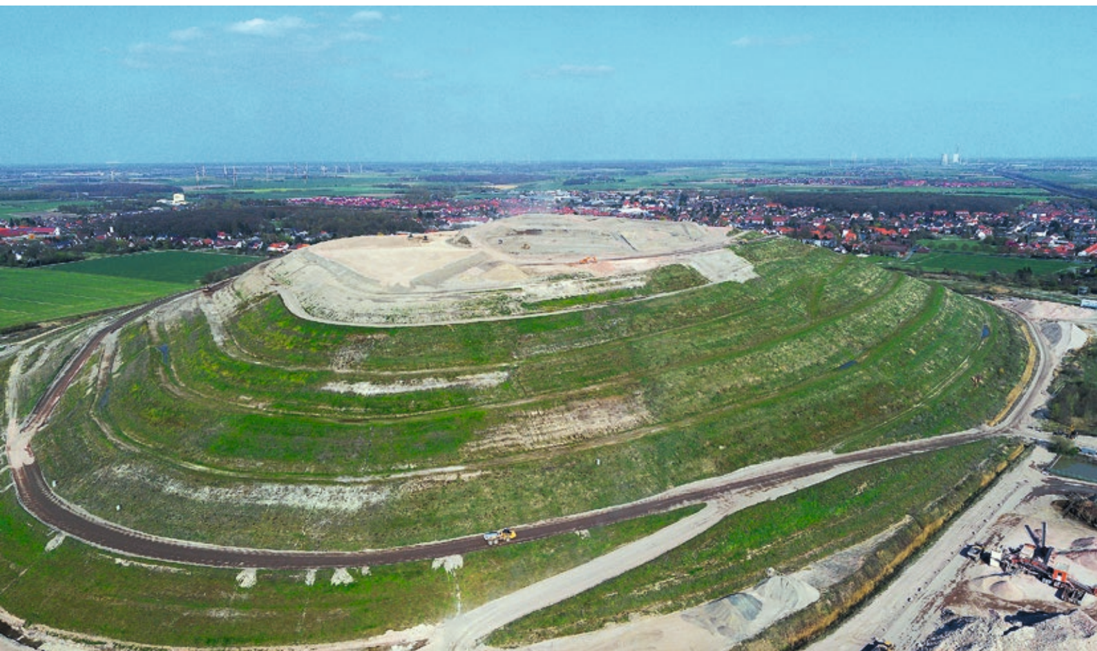
Ansicht der rekultivierten Halde 2020 mit der Herstellung vom Haldentop (Foto K+S)
