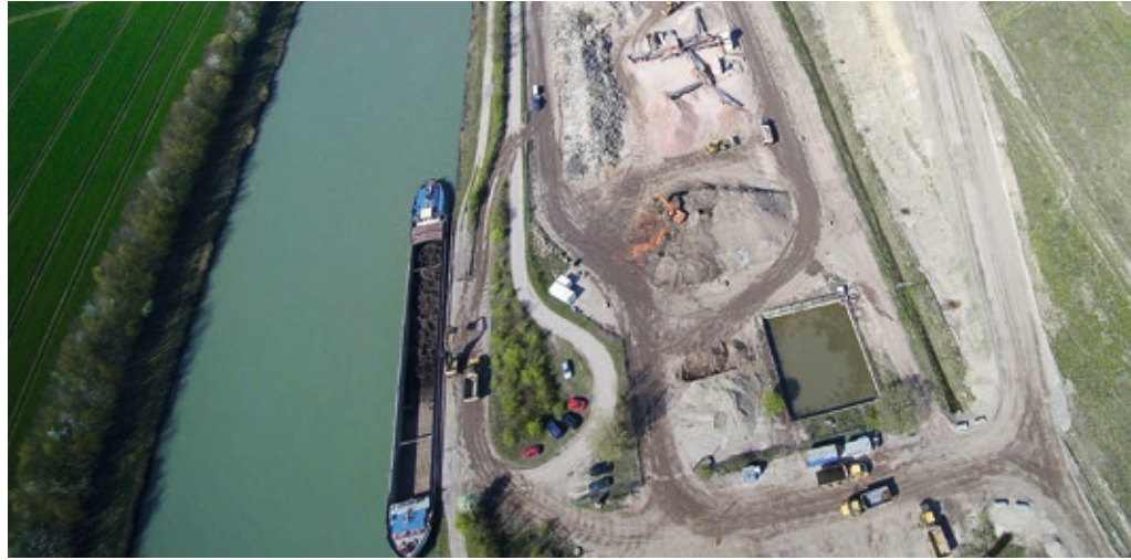
Lage der RC-Anlage mit Schiffsentladestelle (Foto K+S)
