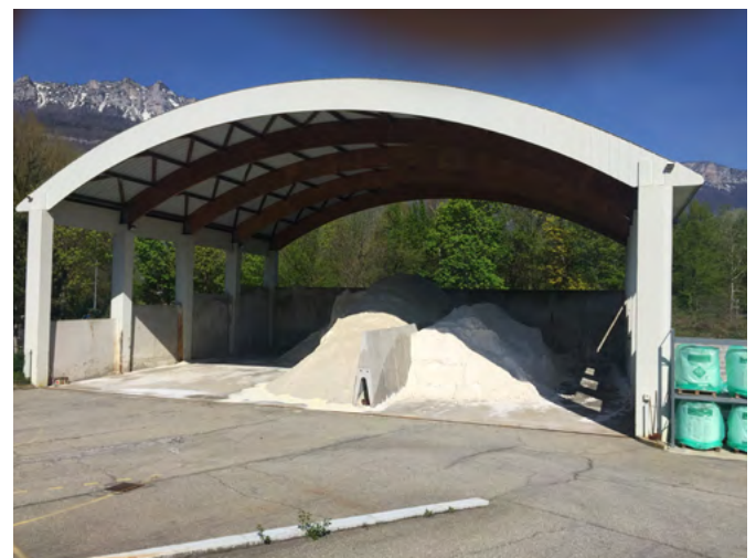
Abbildung 4: Überdachtes Lager für unterschiedliche Salzqualitäten in der Autobahnmeisterei Le Touvet an der A41 (APRR/AREA, Autoroutes Rhone Alpes, Frankreich)
