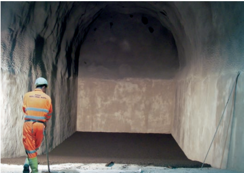
Abb. 7: Entspannter Mineur vor der Pumpkaverne nach Einbringung der Kautschukdichtung und der Schutzbetonschicht auf der Sohle / Relaxed miner in front of the pumping cavern after insertion of the rubber gasket and the protection concrete on the ground
