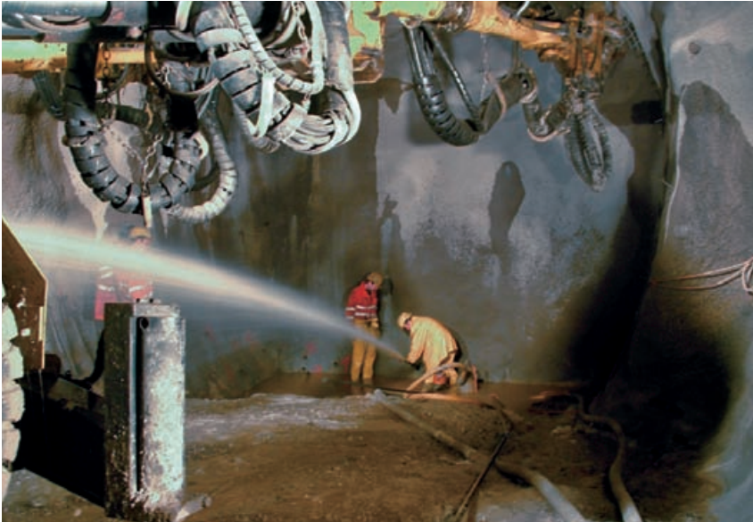
Abb. 6: Unter hohem Druck stehender Wasseraustritt aus der gesicherten Ortsbrust innerhalb der Oberen Dolomit-Formation / Influx of highly pressurized water at the secured heading face within the Obere Dolomit-Formation
