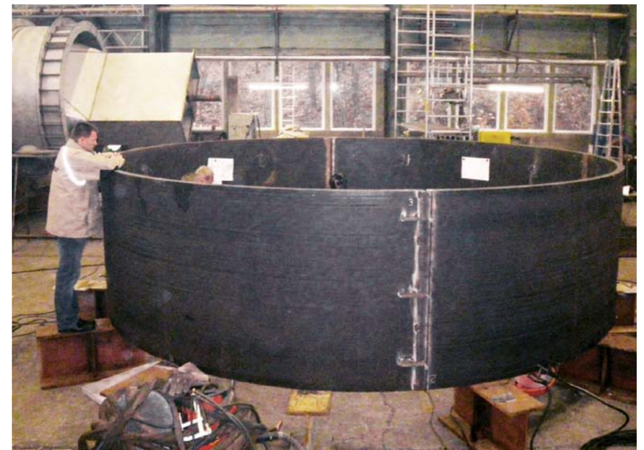
Abb. 7: Probeschweißung / Test welding
