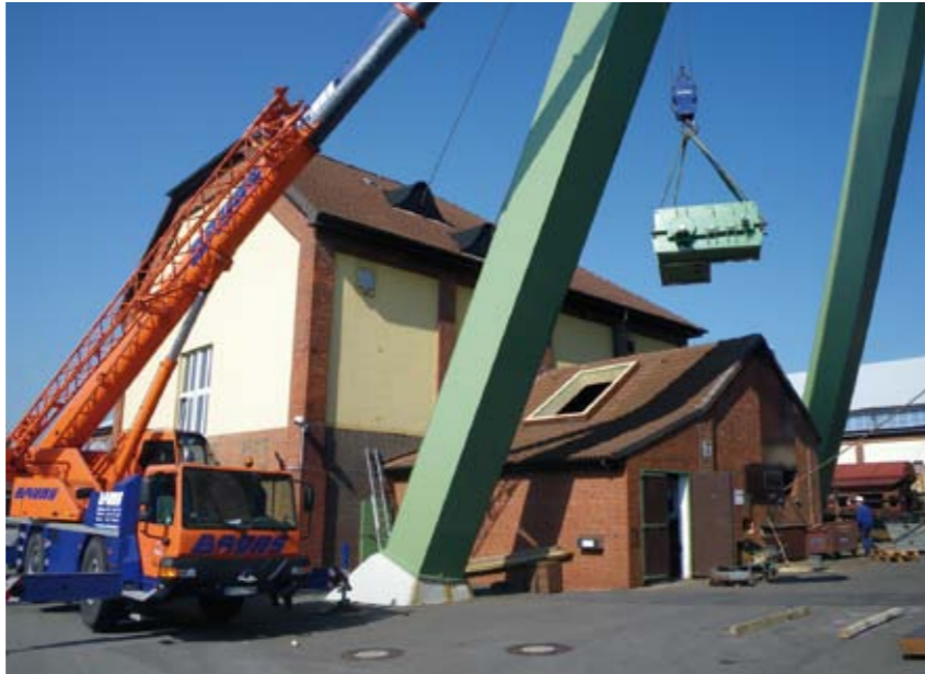
Abb. 5: Einsetzen des neuen Getriebes für die Hilfsfahranlage / Installation of the new gearbox for the auxiliary winding engine
