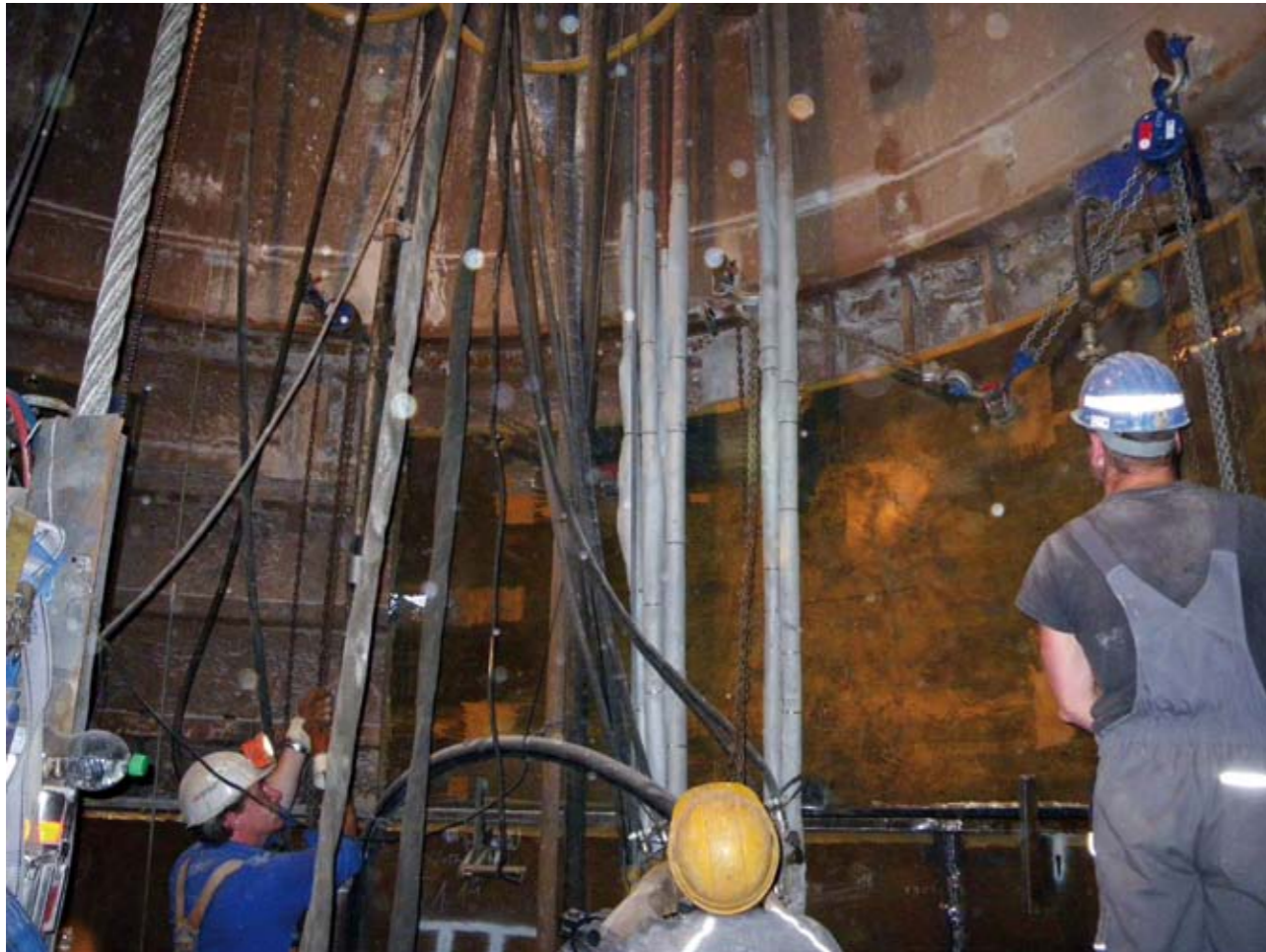
Abb. 11: Aufsetzen der 65 mm starken Bleche auf das Startfundament / Put down from the 65 mm metal plates to the starting foundation
