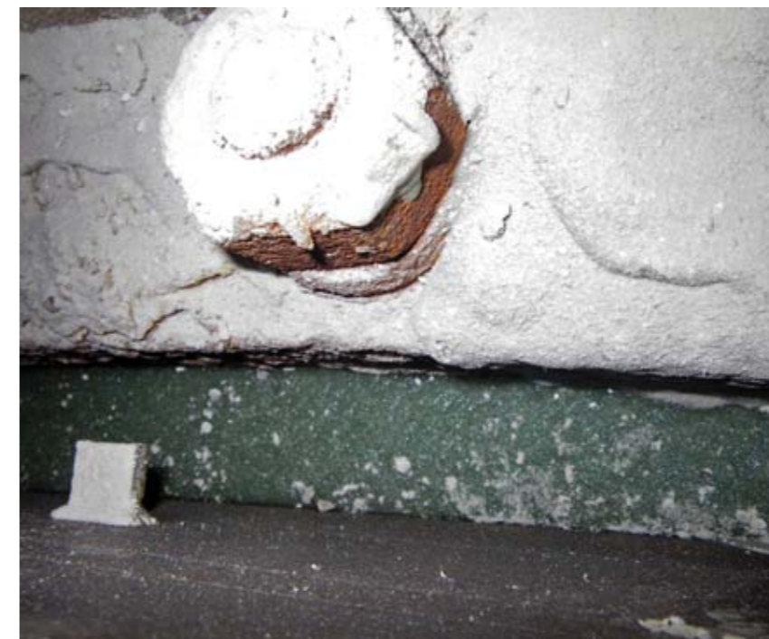
Abb. 12: Einbau des Chemical Seal Ring / Installation of Chemical Seal Ring
