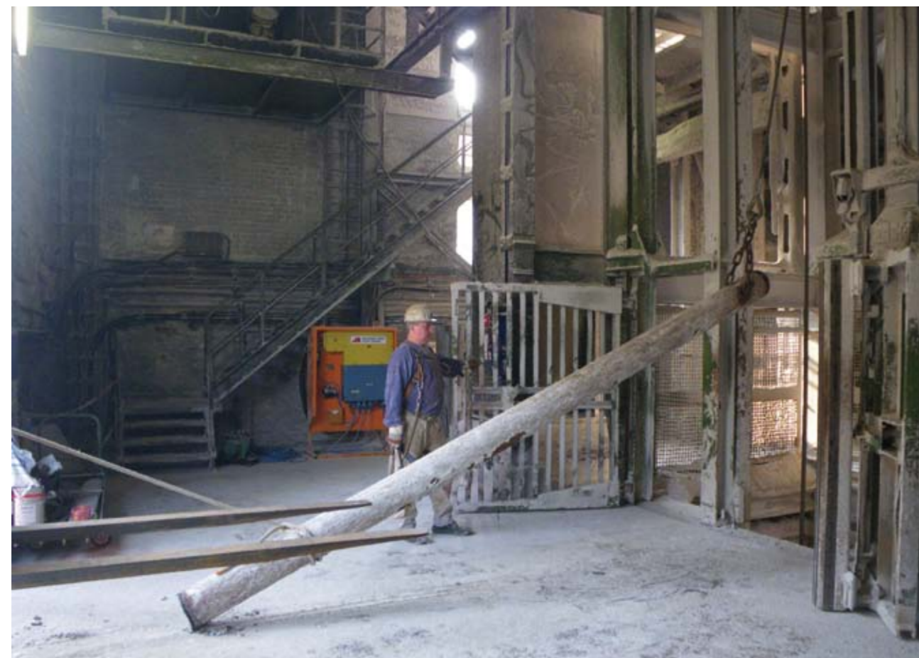
Abb. 6: Ausbau der alten Puderversatzfalleitung / Removal of the old backfilling pipe
