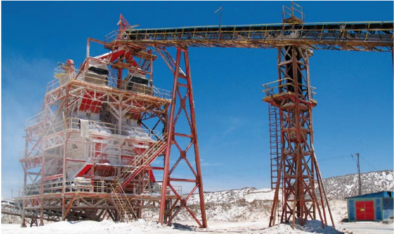
Abb. 6: Aufbereitungsanlage mit Mahl- und Siebeinrichtung (Planta 2). Foto: SPL / Crushing and screening plant (Planta 2) . Photo: SPL
