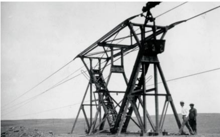
Abb. 3: Seilbahnkonstruktion zum Transport des Steinsalzes vom Tagebau zum Hafen. Foto: SPL / Funicular, used to transport the salt from the mine to the port. Photo: SPL
