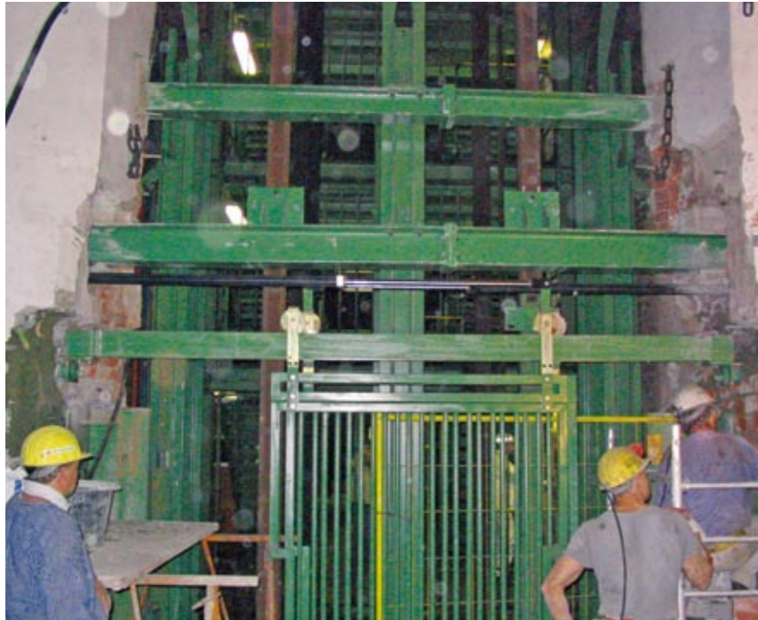
Abb. 7: Umbauarbeiten im Füllort der 1. Sohle / Reconstruction works at 1st level inset
