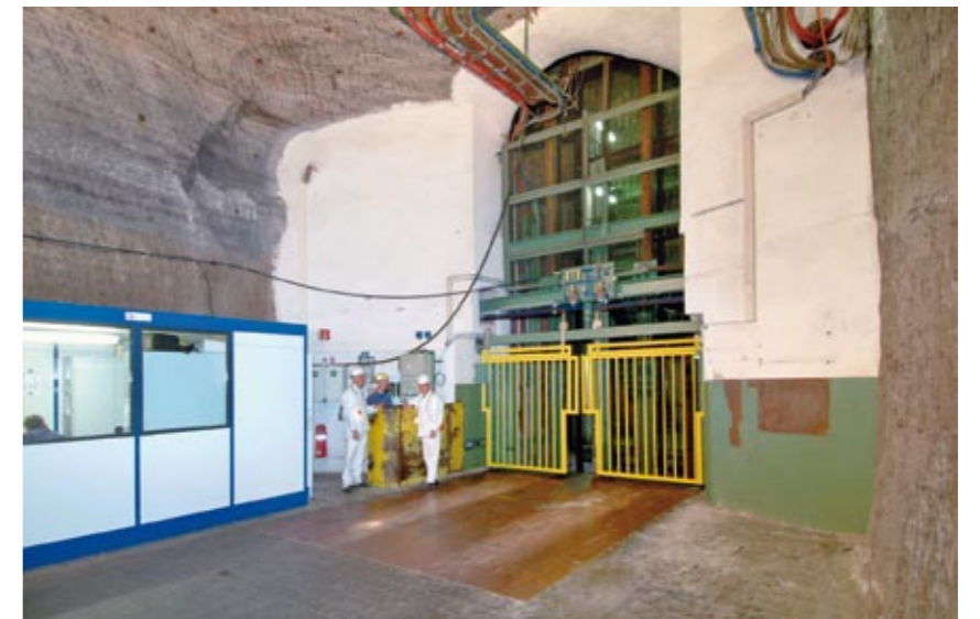
Abb. 10: Füllort der 1. Sohle nach dem Umbau / Inset at 1st level after reconstruction
