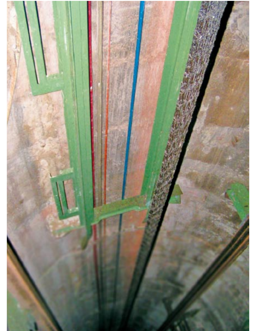
Abb. 6: Neue stoßseitige Eckführungen / New guides at 1st level
