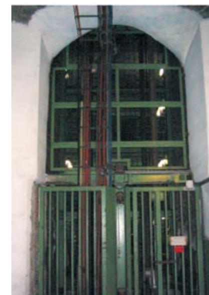
Abb.2: Füllort der 1. Sohle vor dem Umbau / Inset at 1st level before reconstruction
