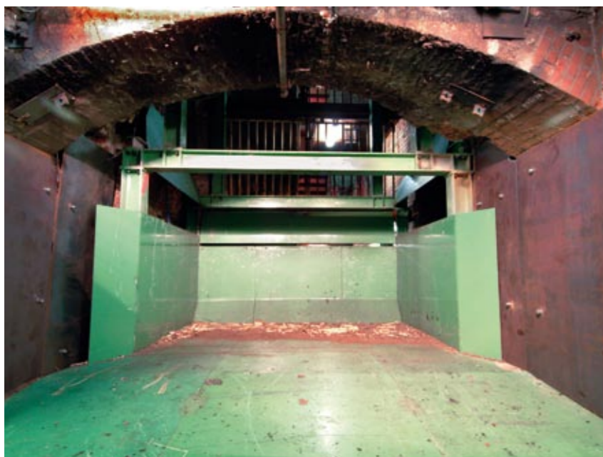
Abb. 8: Neue Schachtabdeckung im Füllort der 2. Sohle / New shaft cover at 2nd level inset
