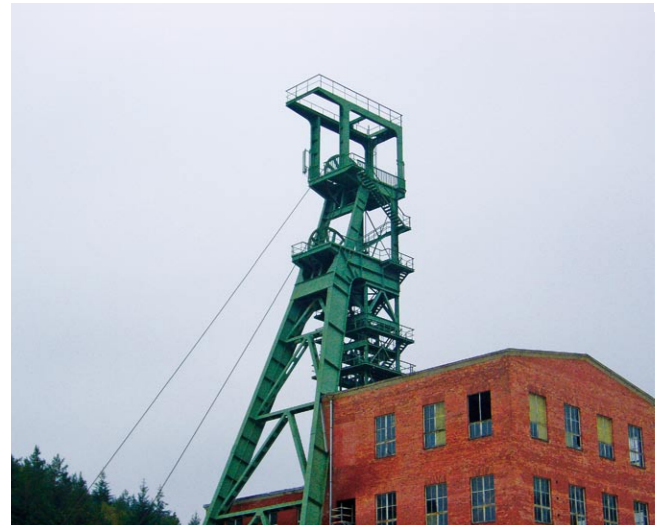
Abb. 1: Schacht Herfa der Schachtanlage Herfa-Neurode | Herfa Shaft
