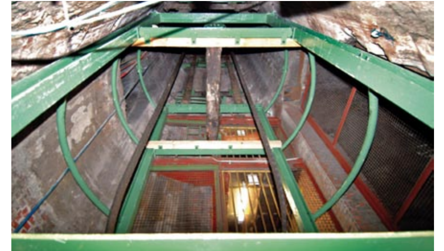
Abb. 9: Neue Spurlattenabstützkonstruktion / New rigid guides support construction
