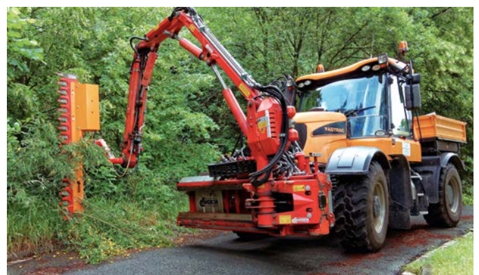
Freischneiden von Wegen im Zugangsbereich von Altstandorten
