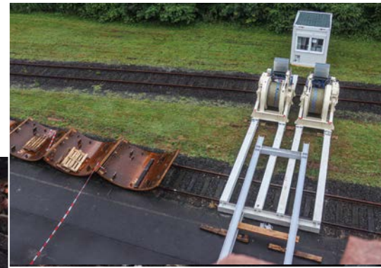
Die aufgestellten Bühnenwinden und Stahlblechsegmente hinter der Schachthalle.
