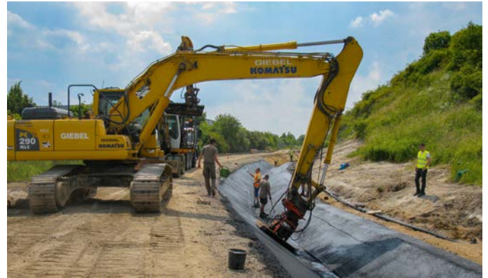
Arbeiten am Neubau des Haldengrabens der Halde Hugo (Werk Bergmannsseggen-Hugo)
