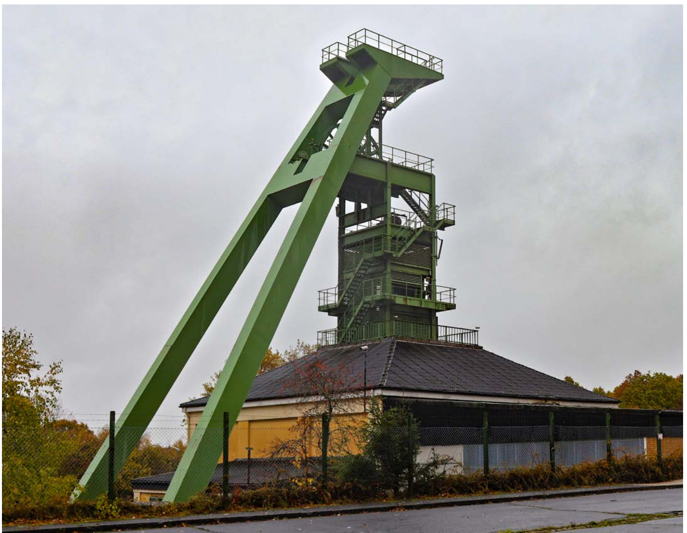
Das markante Fördergerüst der Schachanlage III, Sitz der Einheit Inaktive Werke
