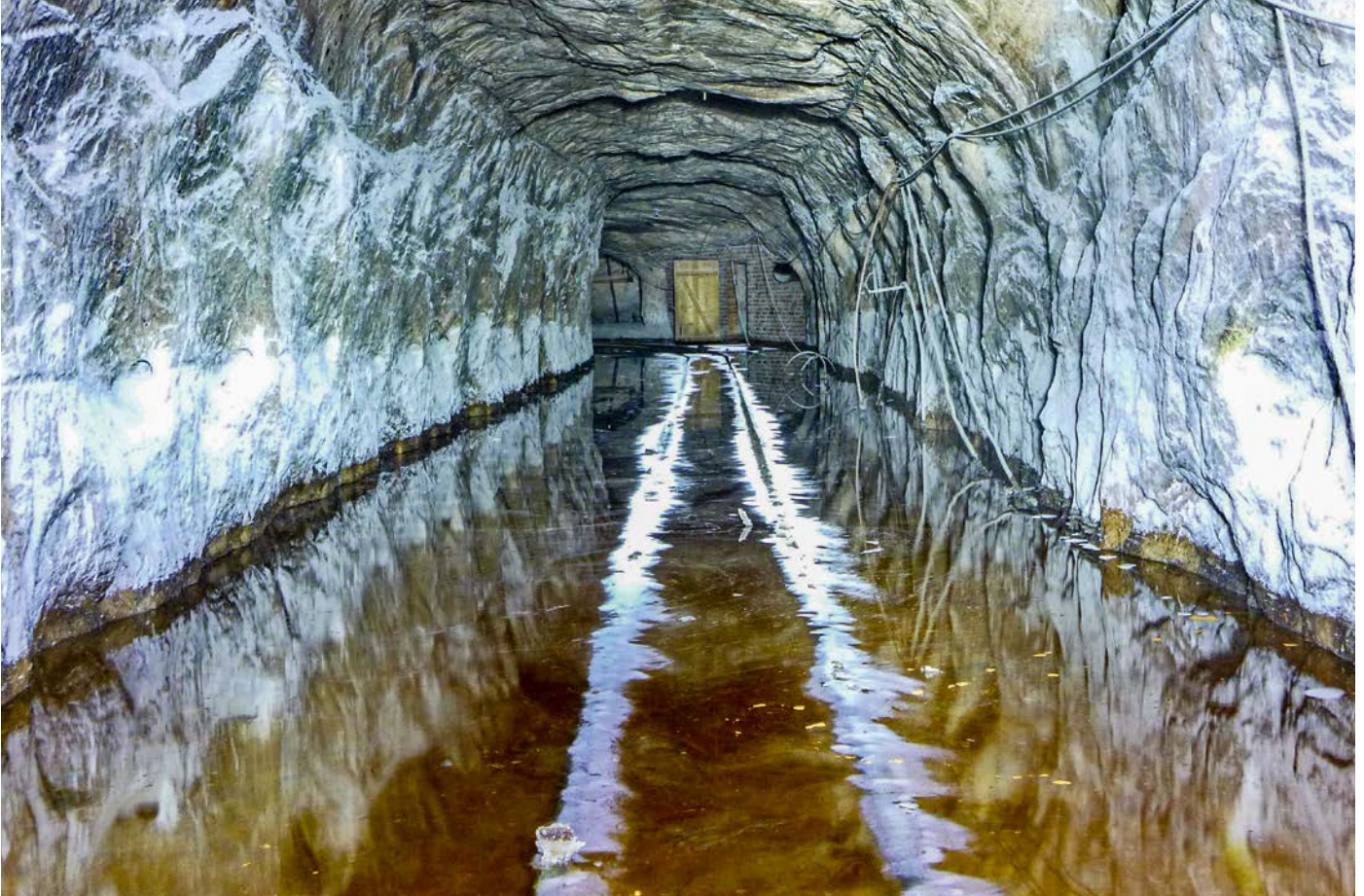
Überflutung auf der 580-Meter-Sohle des mit der Grube Bergmannsseggen-Hugo verbundenen Grubengebäudes Friedrichshall (Sehnde)
