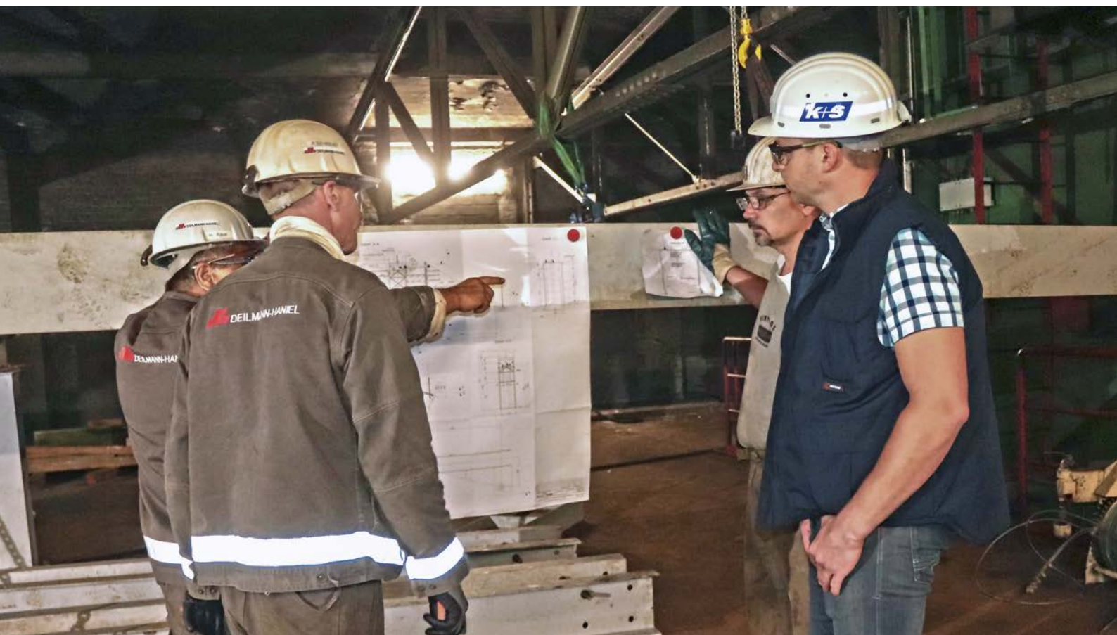
In der Schachthalle des Schachtes Neurode: Beginn der Arbeiten zum Einbau der neuen Vorbau säule; rechts: Projektkoordinator Florian Deiseroth; links: Mitarbeiter der beauftragten Firma Redpath-Deilmann.
