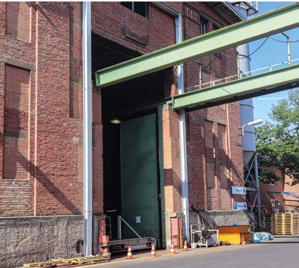
Der Ort des Geschehens, die Schachthalle von Schacht Neurode
