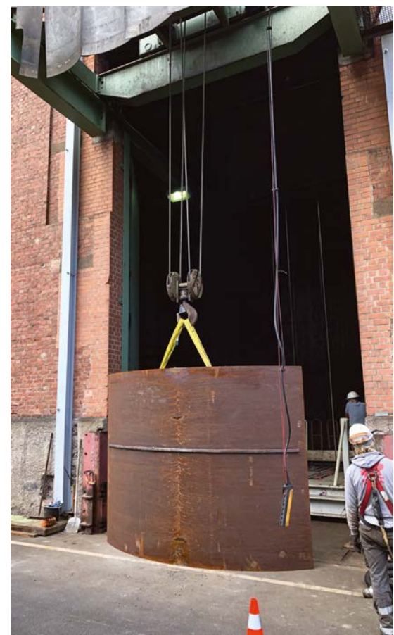
Ein Stahlblechsegment ist für den Schachttransport vorbereitet.
