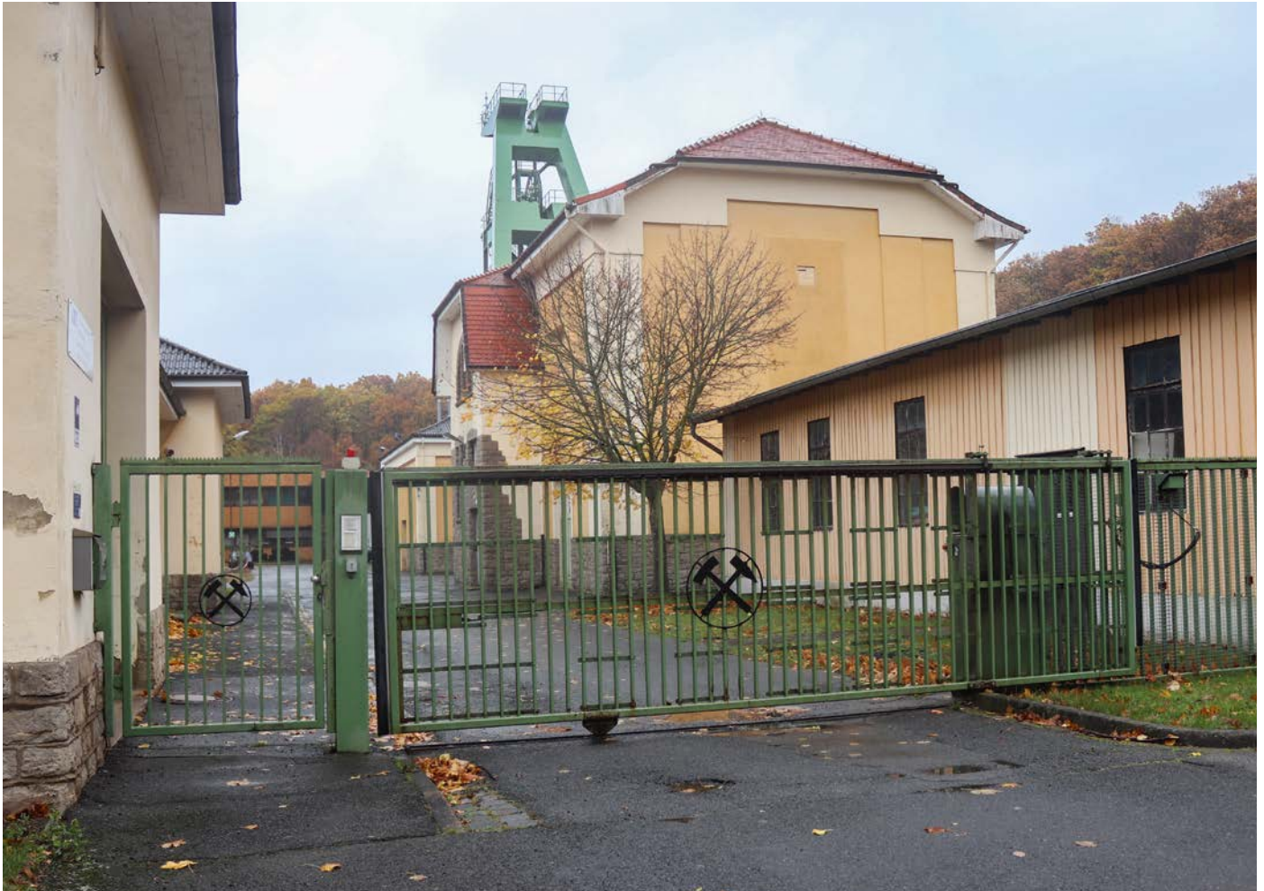
Der Zugangsbereich zur Schachtanlage III, Sitz der Einheit Inaktive Werke in Bad Salzdetfurth
