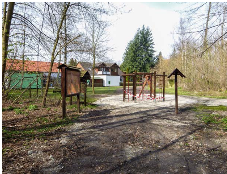
Diese Geräte eines Spielplatzes standen zu Beginn des Projektes im Wege und mussten vorübergehend demontiert werden. Nach Abschluss des Projektes wurden sie wieder zusammen- und aufgebaut, der Spielplatz in den alten Zustand zurückversetzt.
