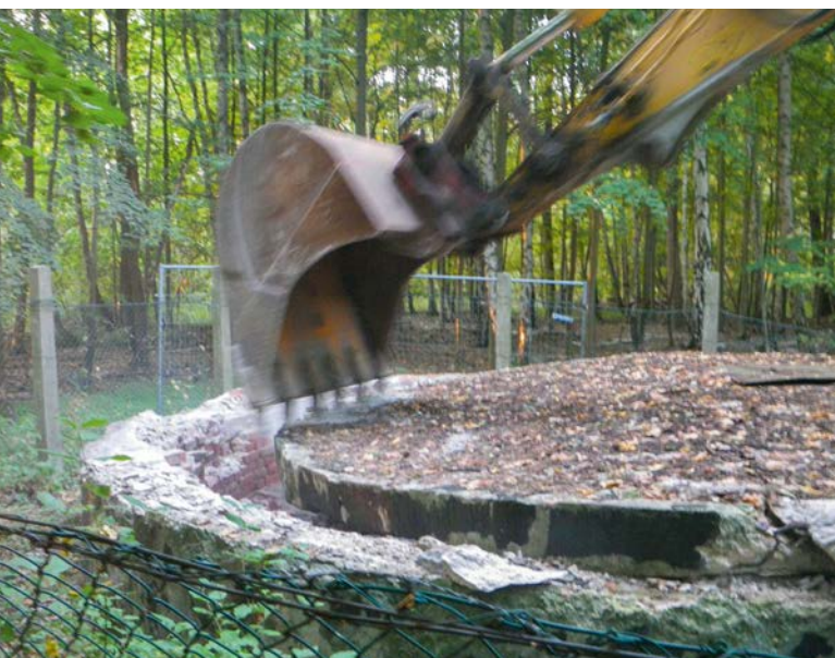
Die Vorarbeiten wurden von externen Firmen nach Vorgabe der IW ausgeführt (Wegebau, Abriss, etc.).
