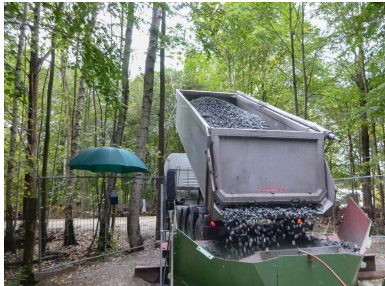
Über eine Schurre wird der per LKW angelieferte Hartgesteinsschotter und Kies in den Schacht abgekippt. Insgesamt wurden in diesem Schacht 21.000 Tonnen Material eingebracht.
