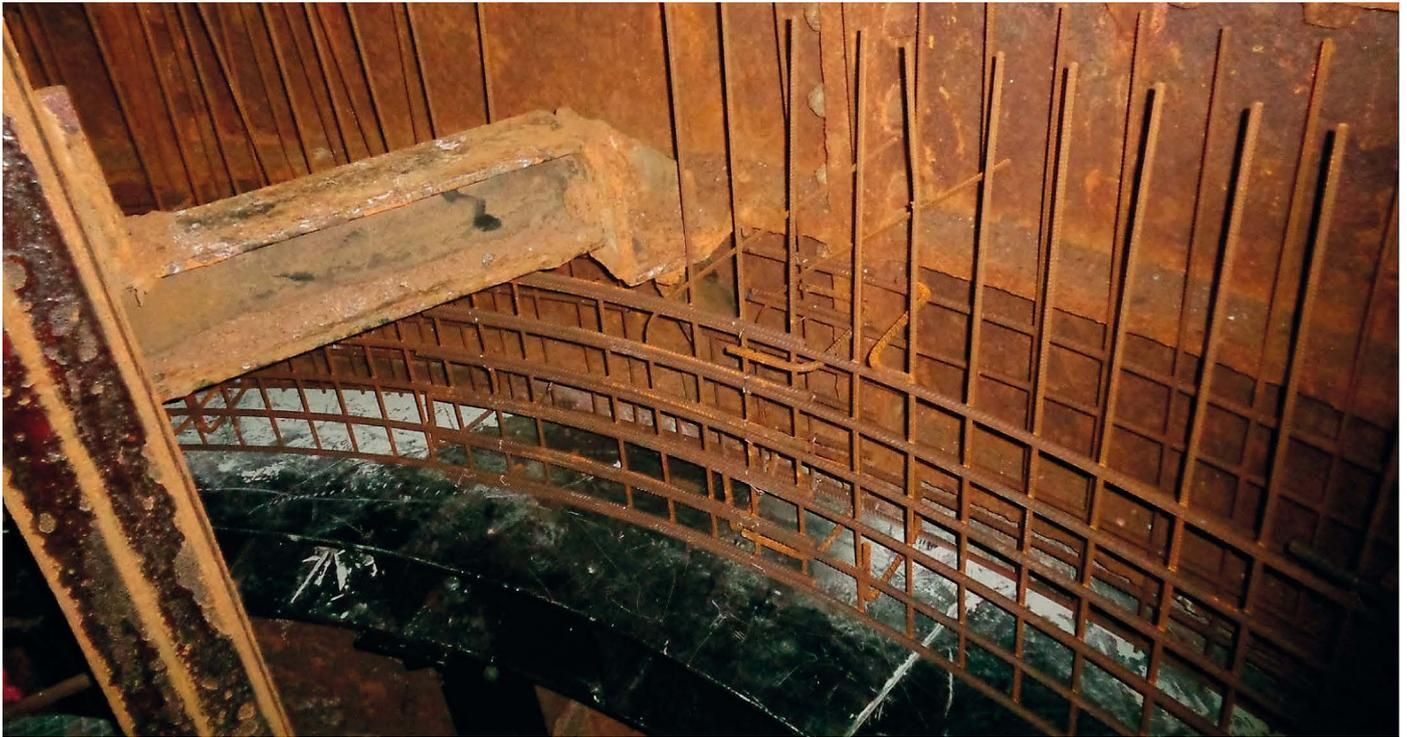
Abbildung 1: Schacht Borth 2 Einbau Ausbauperkürkung (4,3 – 57,4 m) – Einbau Grundring
