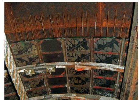
Abbildung 2: Schacht Borth 2 Einbau Ausbauperkürkung (4,3 – 57,4 m) – Einbau Ortbeton mit Polygonschalung
