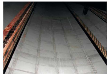
Abbildung 3: Schacht Borth 2 Einbau Ausbauperkürkung (4,3–57,4 m) – Bauwerk nach Fertigstellung
