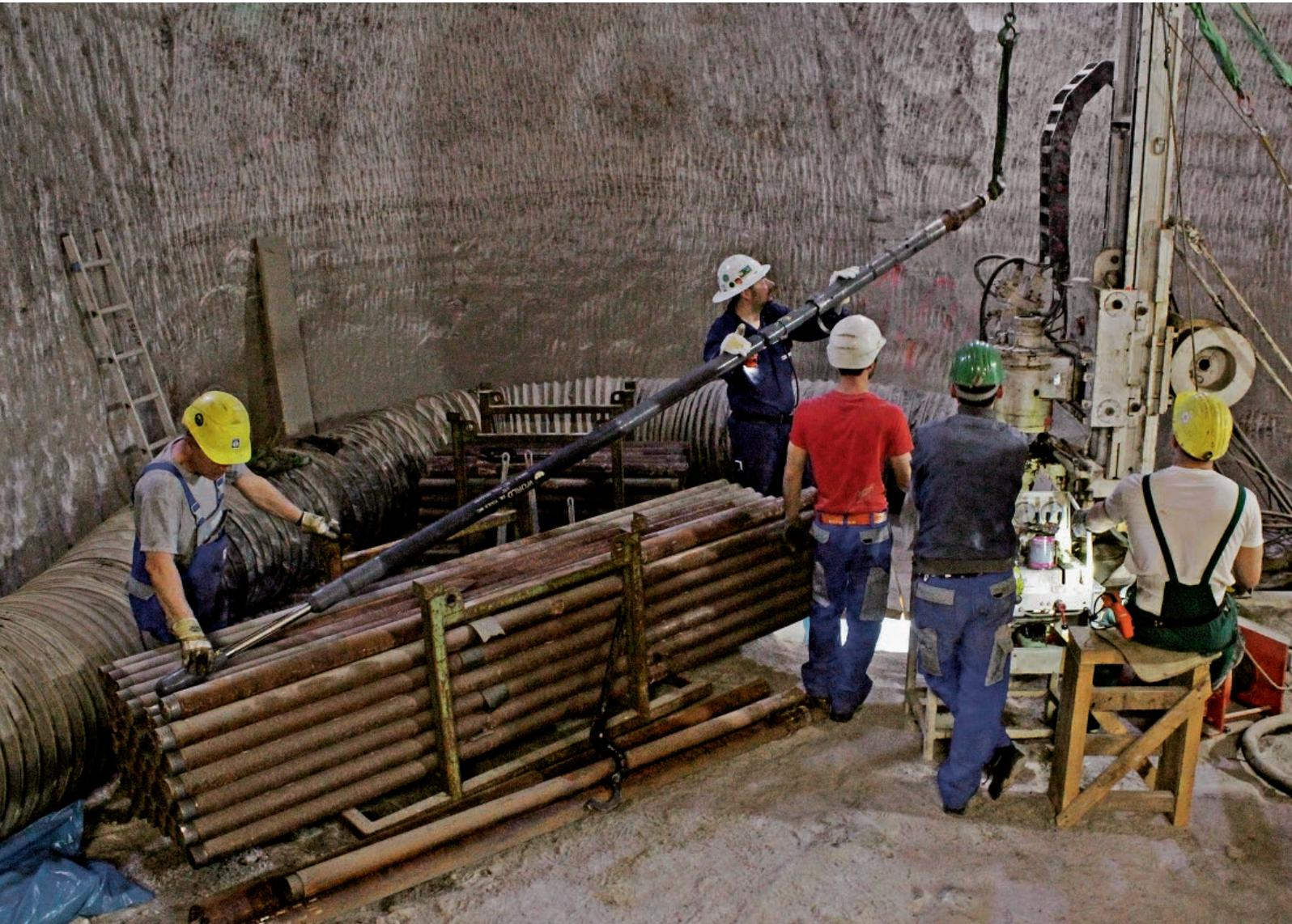
Abbildung 5: Setzen des Schlauchpackers zur Vorbereitung des langzeitsicheren Bohrlochverschlusses
