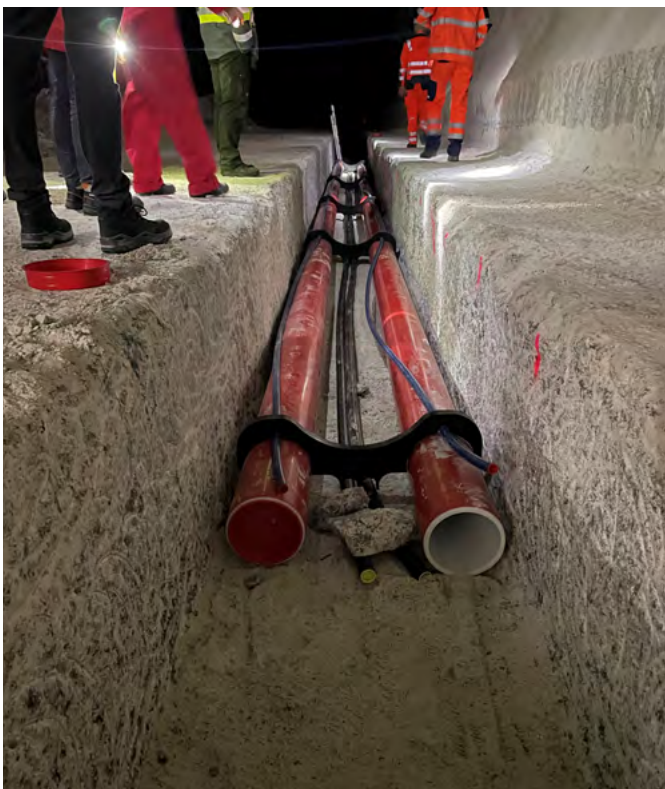
Abbildung 5: Probekabelgraben [Foto: SWS]
