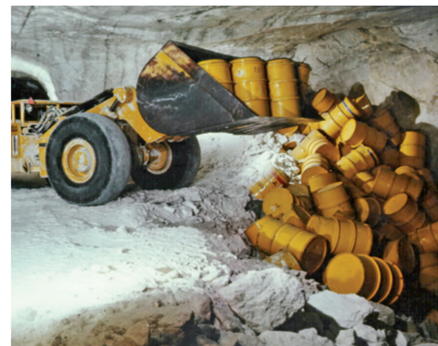
Abb. 8: Einlagerung von schwachradioaktiven Abfällen (Abkipptechnik) mit Frontschauelladern / Disposal of low-level waste (dumping) with front loader
