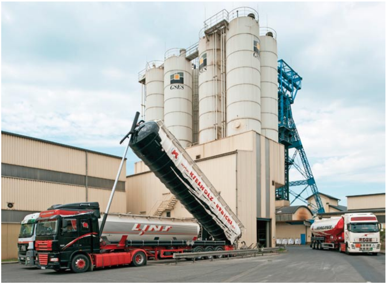
Entladung Fahrzeuge Schacht V / Cargo dispatch at Shaft 5
