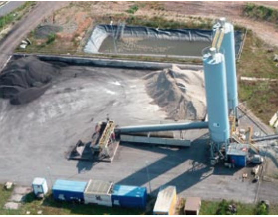
Luftaufnahme der KBH-Anlage / Aerial View of the KBH Plant
